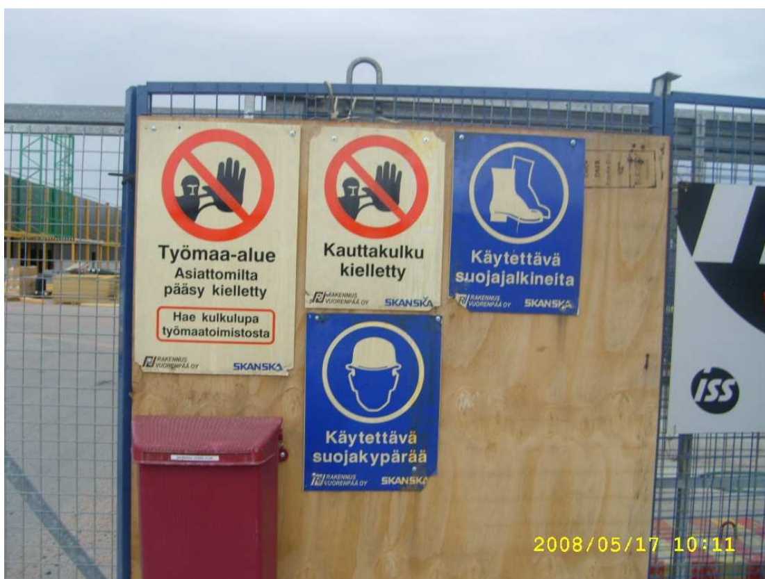
Kuva 11. Kuva työmaan portin läheisyydestä.
