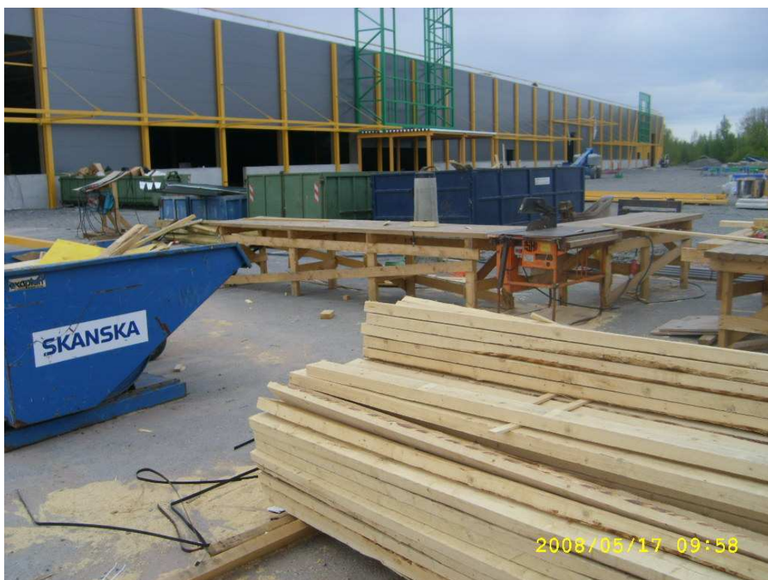
Kuva 8. Kirvesmiehen työalue. Kuvassa näkyy sirkkeli, puutavara, työpöytä ja jätepieste.
