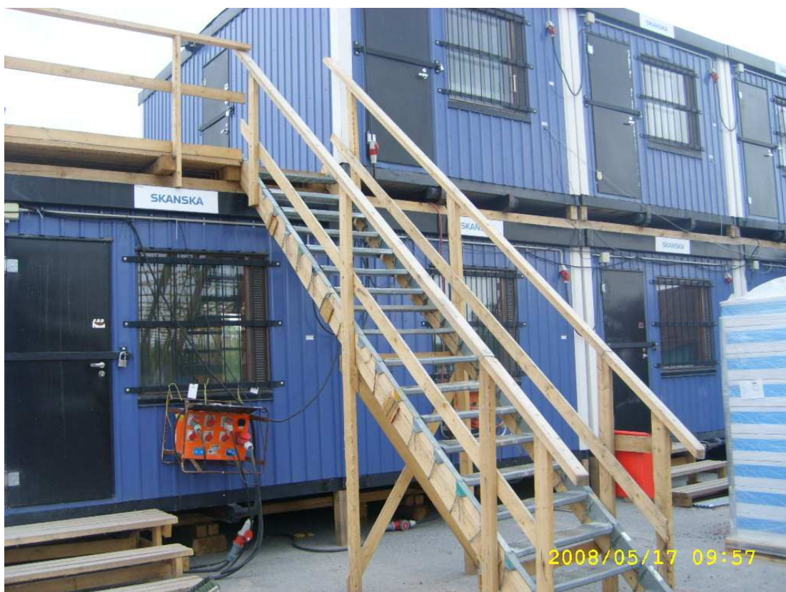
Kuva 12. Työmaatilat. Kulku työmaatilojen toiseen kerrokseen tapahtuu kuvassa näkyvillä portailla.
