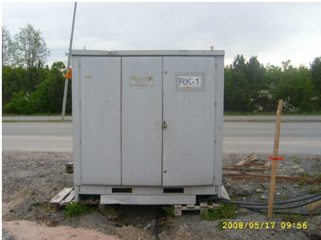
Kuva 6. Sähköpääkeskus (400A).
