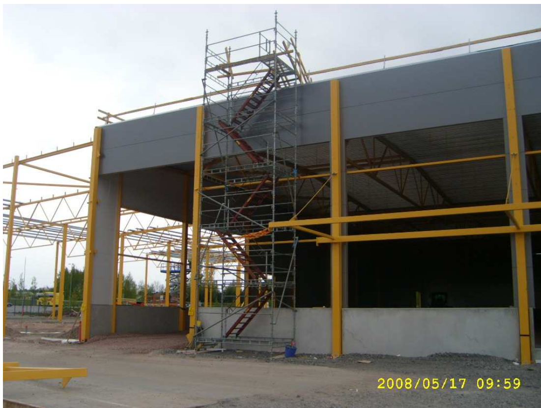
Kuva 13. Kulku katolle tapahtuu kuvassa näkyvän telineen avulla.
