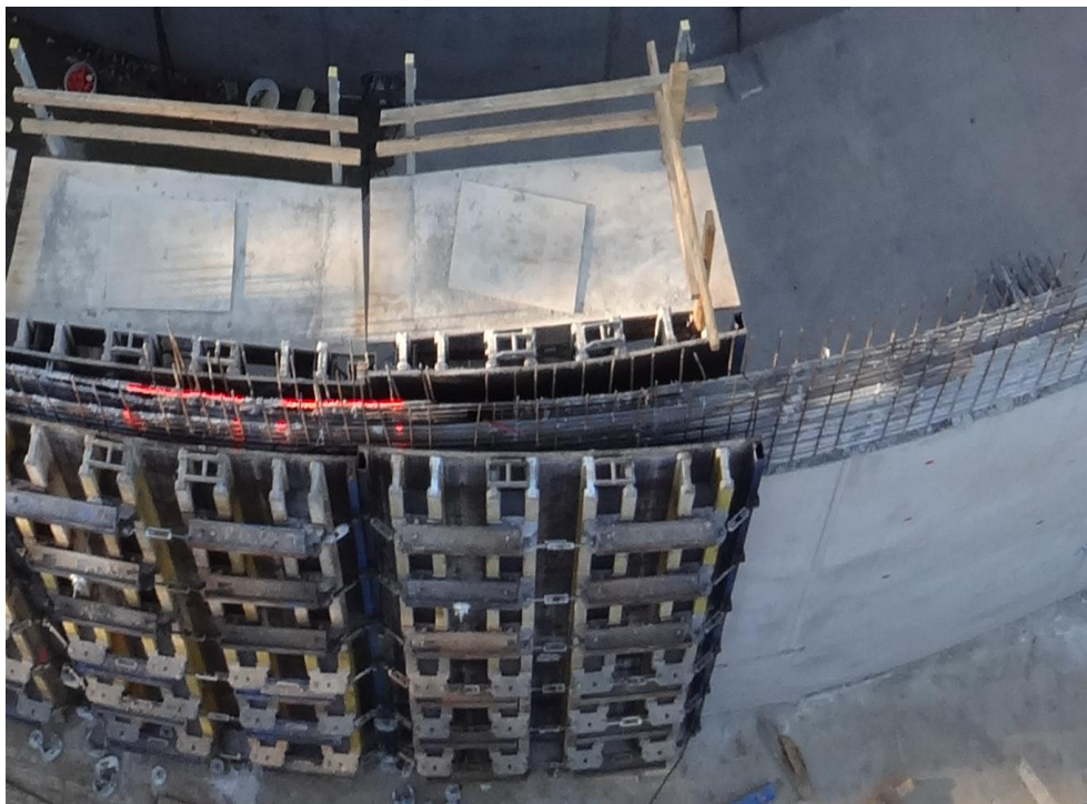
Kuva 9. DOKA- kaareva seinämuotti purkuvaiheessa. [10.]
