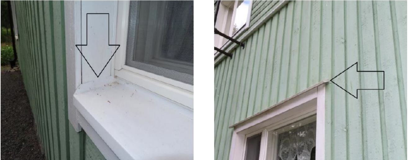
Kuva 7. Rakennuksen ikkuna ulkopuolelta (Syrjämäki, 2021).
