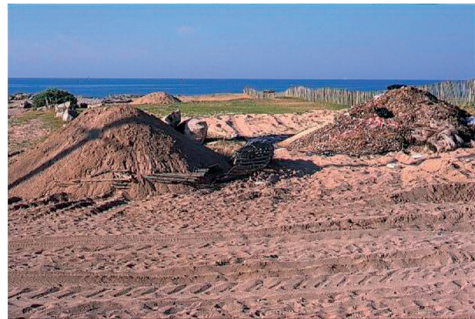
Kuva 9.9 Puhdistustyömaalla on dumpattu seulontajätettä kasvillisuuden päälle (FOST/CEDRE).
