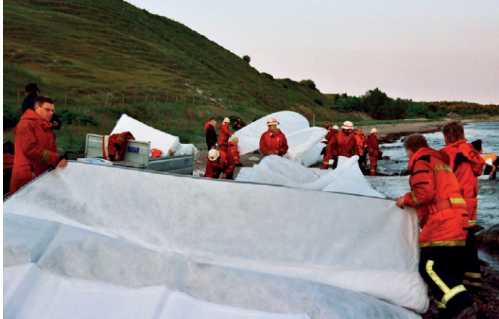
Kuvat 9.2 ja 9.3 Öljylautan uhkaamien rantojen vesirajan etukäteissuojaaminen suojamatoilla helpottaa huomattavasti rannan puhdistamista (Oljeplan för Sydöstra Skåne 2006).
