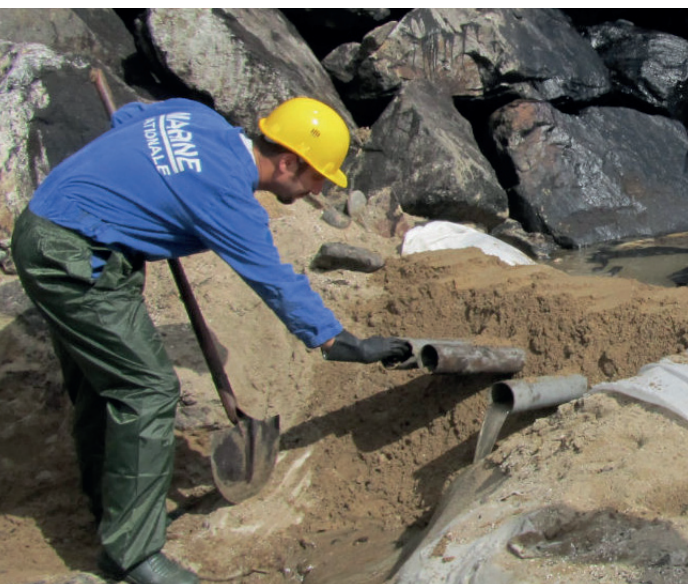
Kuva 9.10 Pesuv veden dekantoiminen (M. Pascale 2010).
