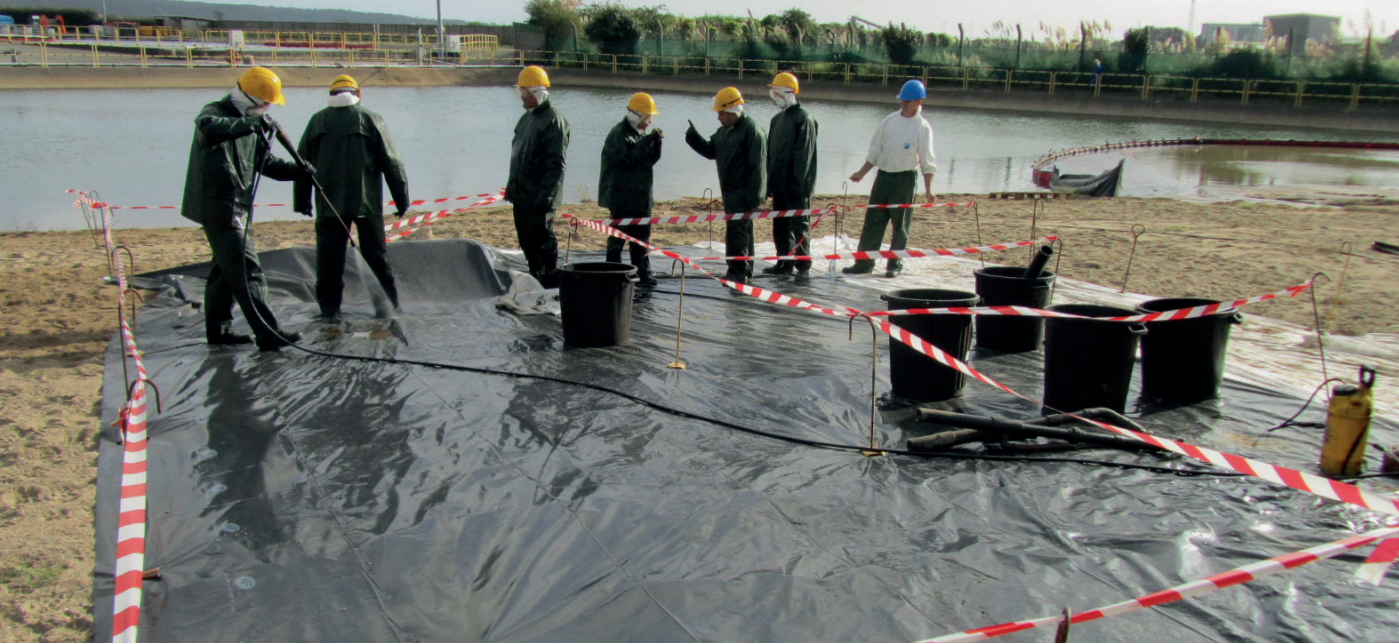
Kuva 11.4 Keräyspiste, jonka yhteydessä on puhdistautumispiste. Kulkuväylä pressualueen vieressä on suojattu leveällä imeytysmatolla (M. Pascale 2010).
