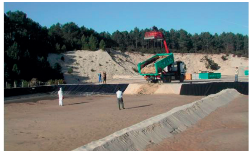
Kuva 11.8 Välivarastointipisteen pohjatöitä (FOST 2009).
