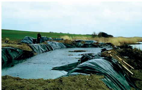
Kuva 11.5 Baltic Carrierin ja Ternin yhteentörmäys (2001, Tanskan ja Saksan rannikolla); alueelle tuotu puskurialtaan pengerrystä varten maata. Kuopan suojaaminen muovitetulla kalvolla (Cedre).
