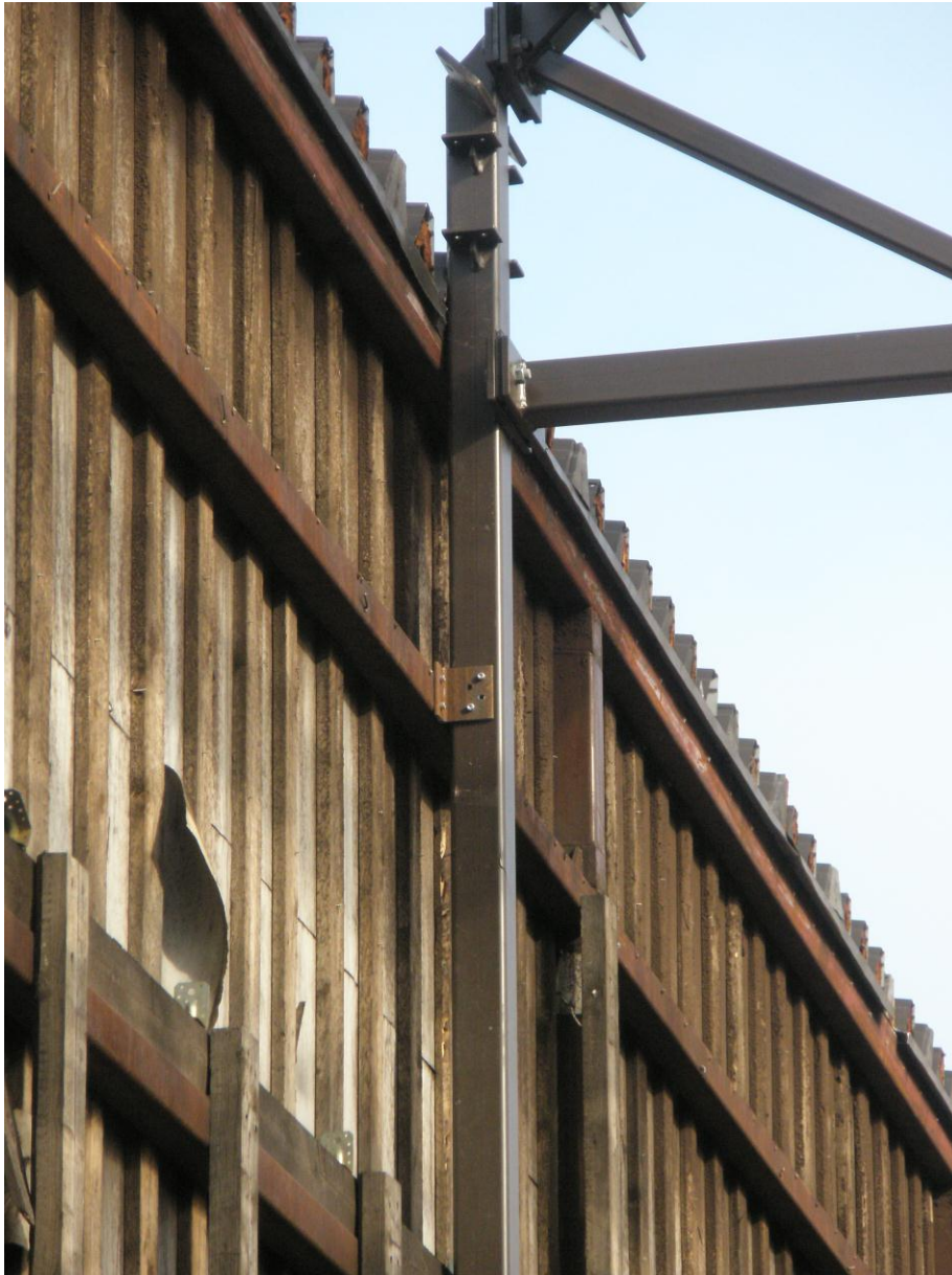
Kuva 20. Runkojen välinen liitos.
