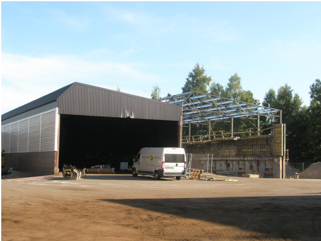
Kuva 1. Hakevaraston muoto rakennusvaiheessa.
