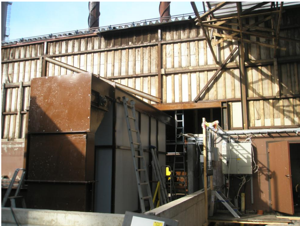
Kuva 21. Vanhan rungon tuenta.
