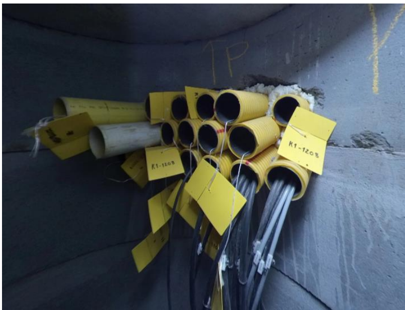
KUVA 34. Suojaputkien merkintöjä vetonaruissa (Raitiotieallianssi 2021).
