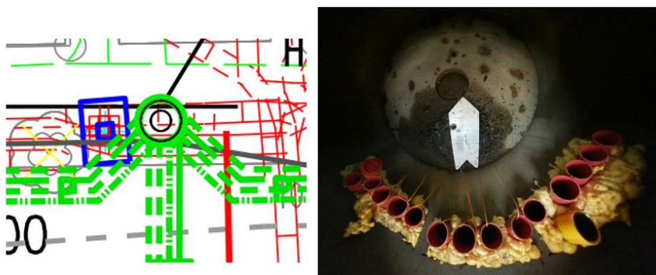
KUVA 26. Putkireitin sisään- ja ulostulo kaivon samalla seinustalla, suunnitelma ja toteutus (Raitiotieallianssi 2017, muokattu).
