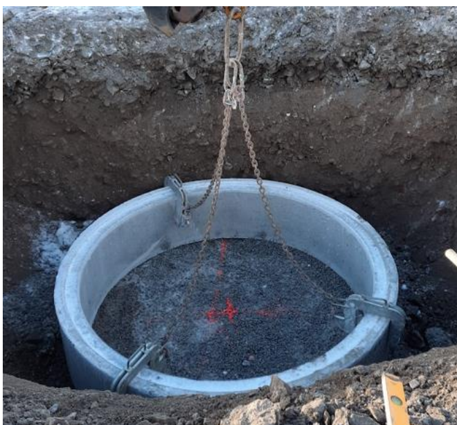
KUVA 17: Kaivon renkaan asennus (Raitiotieallianssi, Hely-Anna Mäki 2023).
