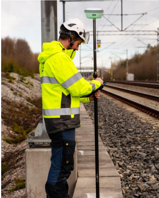
KUVA 21. Satelliittimittausta GNSS-antennilla varustetulla kartoitussauvalla (I5navigation.fi).
