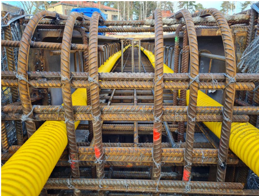
KUVA 12. Suojaputkia sillan rakenteessa (Raitiotieallianssi, Veetu Helkiö 2021).
