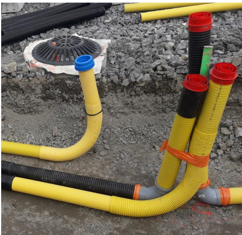
KUVA 27. Varikon liukuportin perustusten välisen putkireitin toteutus (Raitiotiealliassi 2019).
