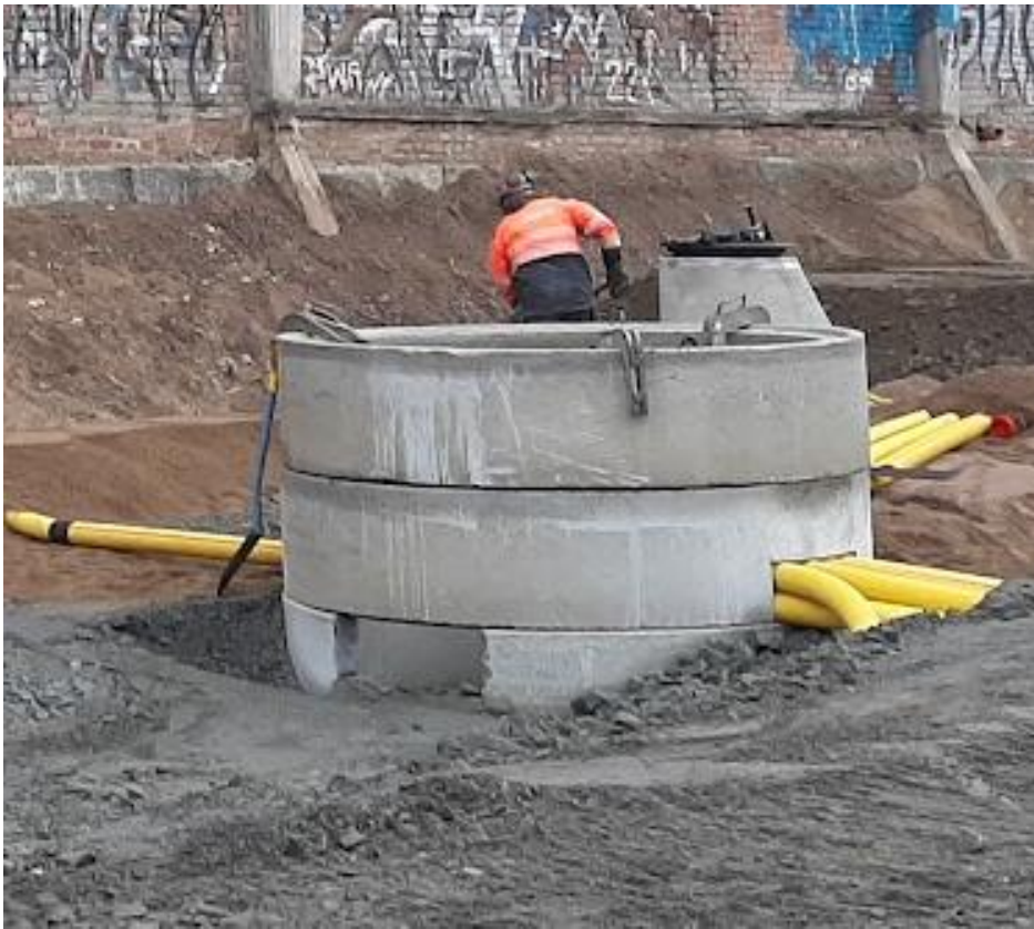
KUVA 18. Raitiotien kaapelikaivo ja suojaputkille sahatut läpiviennit (Raitiotieallianssi, Sari Valjus 2022).
