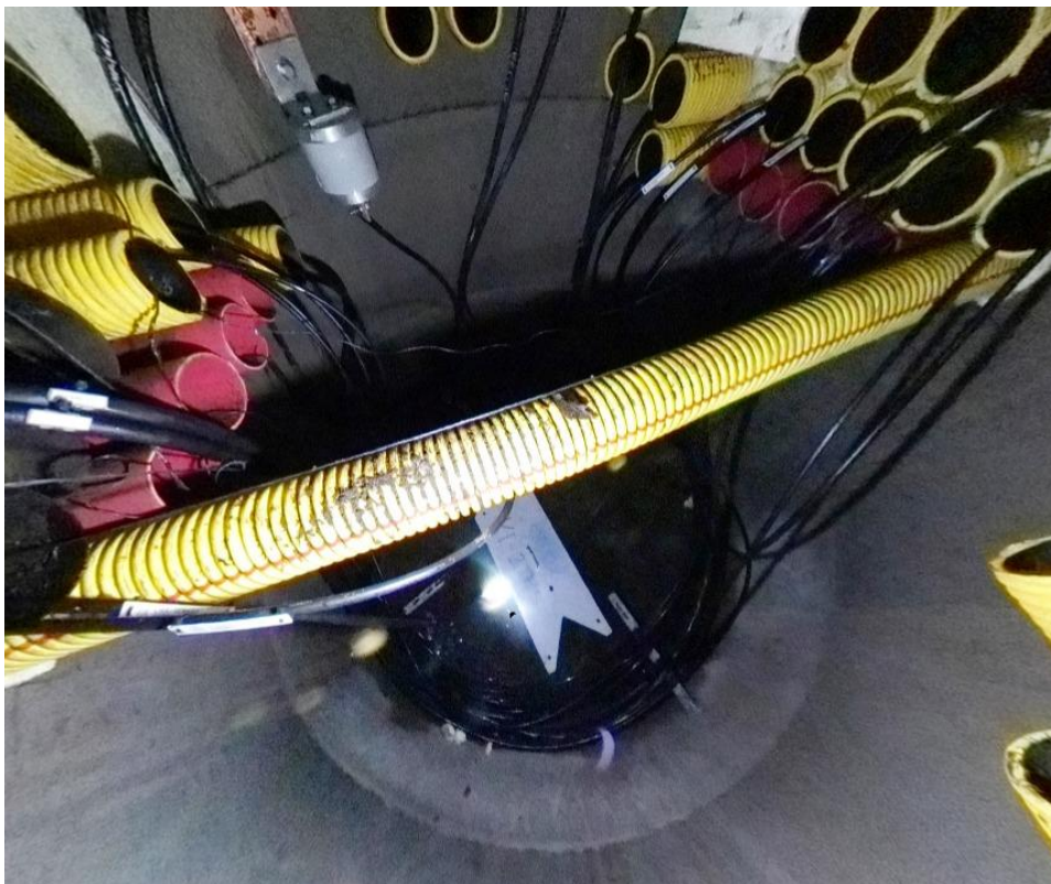
KUVA 31. Kaivon läpi asennettu suoja-putki (Raitiotieallianssi 2020).
