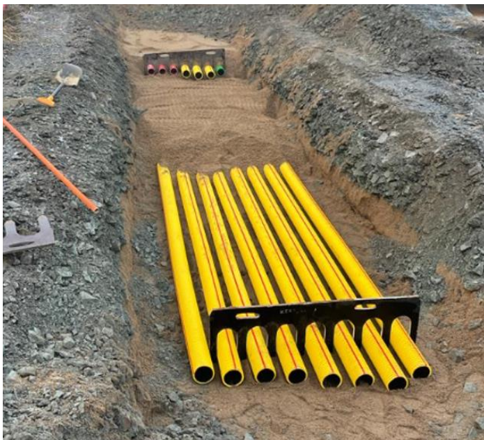
KUVA 15. Runkoreitin suoja-putkia ja 50 mm:n välin varmistava vanerikampa (Raitiotieallianssi, Juuso Aaltonen 2022).
