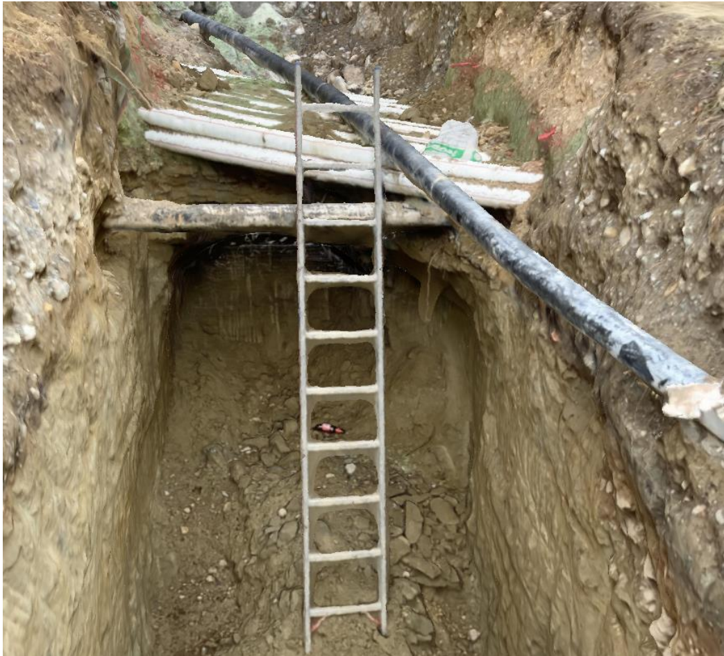
KUVA 24. Kuvakaappaus kaivannon pistepilvimallista (PIX4Dcatch demo 2020).
