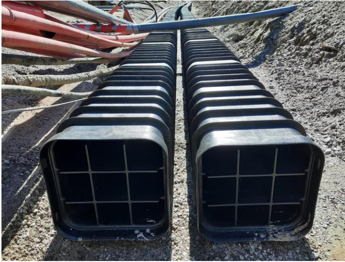
KUVA 10. Cubis Multiduct-kaapelikanavia Helsingin Raide-Jokeri-raitiotiehankkeella (Raide-Jokeri 2020).
