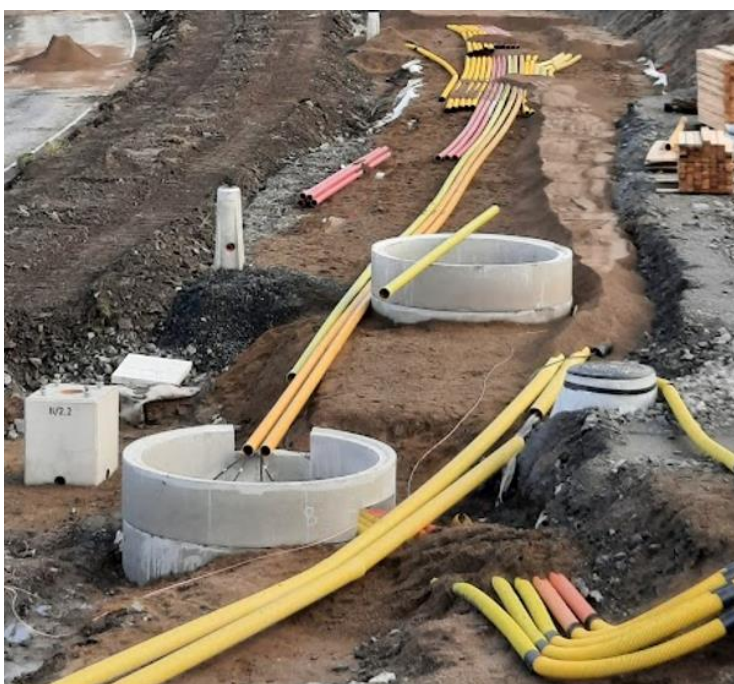
KUVA 16. Kaapelireitin rakentamista Paasikivenkadulla (Raitiotieallianssi, Sonja Juntunen 2022).
