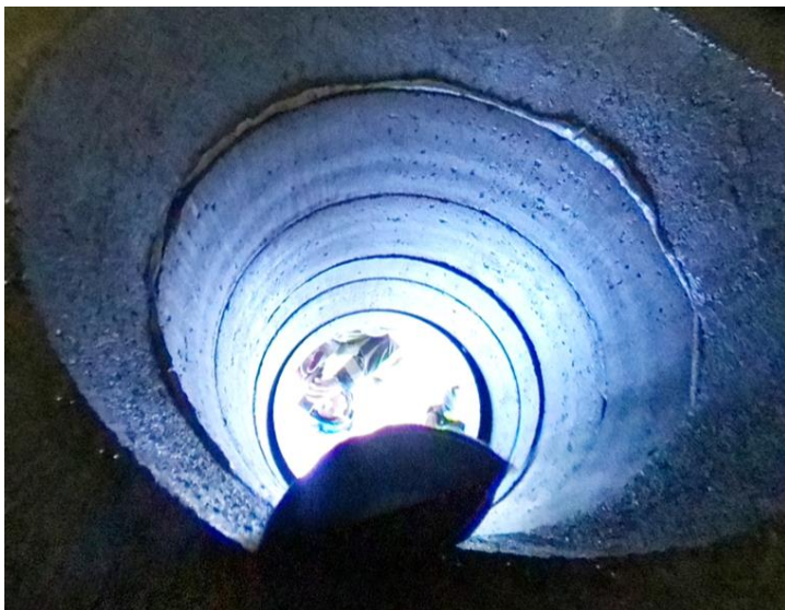
KUVA 29. Korotusrenkailla tehty kulkuputki kaivoon (Raitiotieallianssi 2020).
