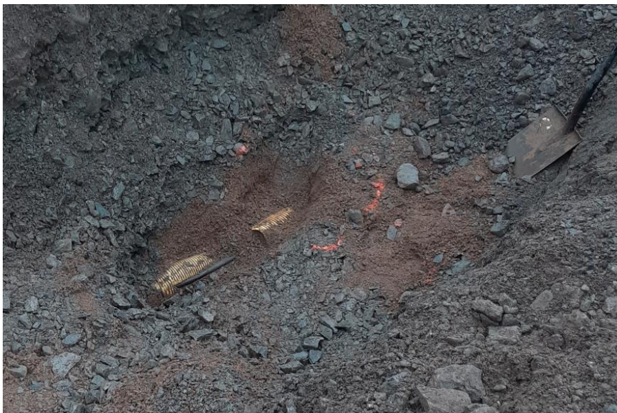
KUVA 25. Esiin kaivettuja kaapelireittejä (Hely-Anna Mäki 2023).
