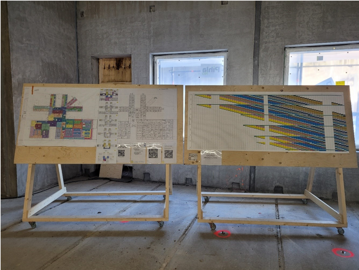
Kuva 1. Visuaalinen infotaulu työmaalla.
