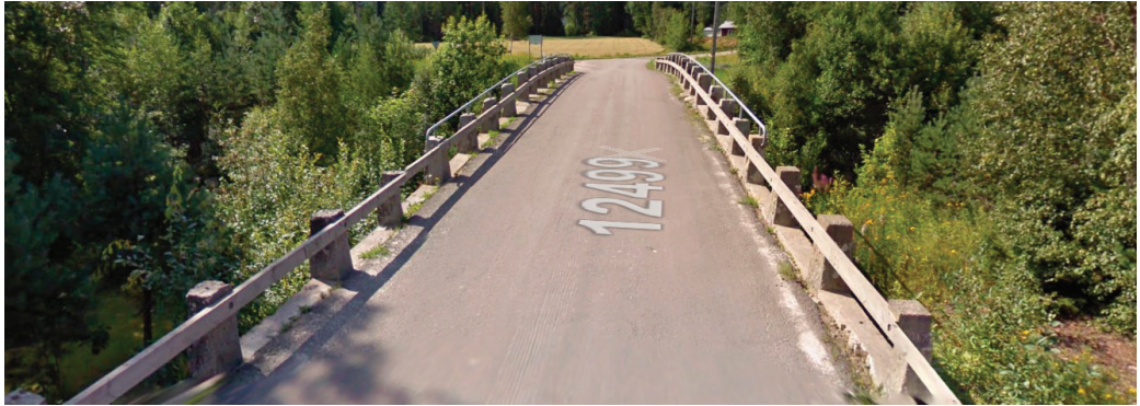
Kuva 31. Nansion silta, Sorolantie. © Google Maps 2018.
