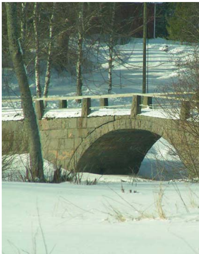
Vanhat sillat ja muut ylityspaikat ovat historiallisten teiden huippukohtia. Yllä Kivisilta Käyrässä. Alla Vintalantie Rähälän rotkossa.
