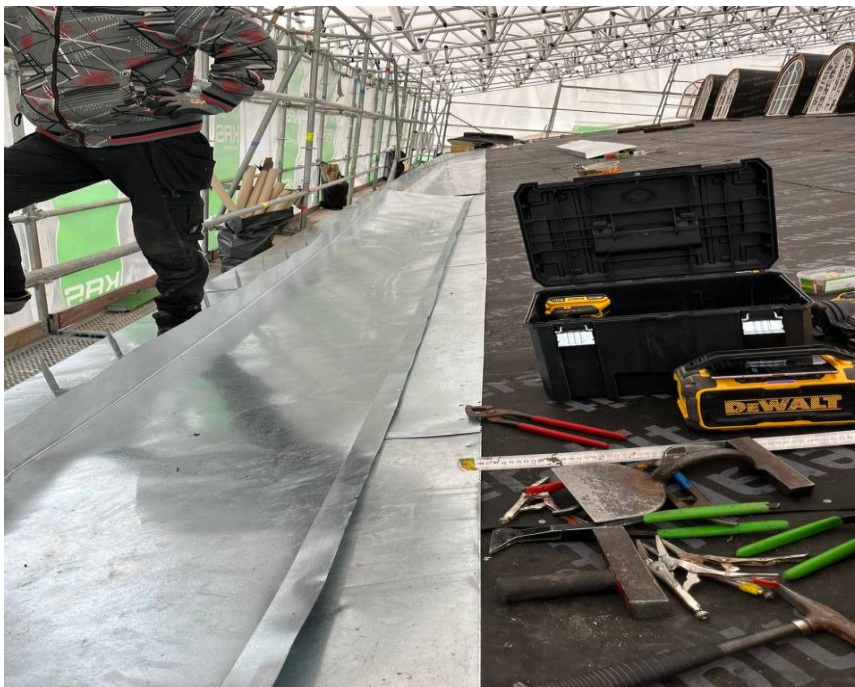
Kuva 4. Rännilistan asennus
