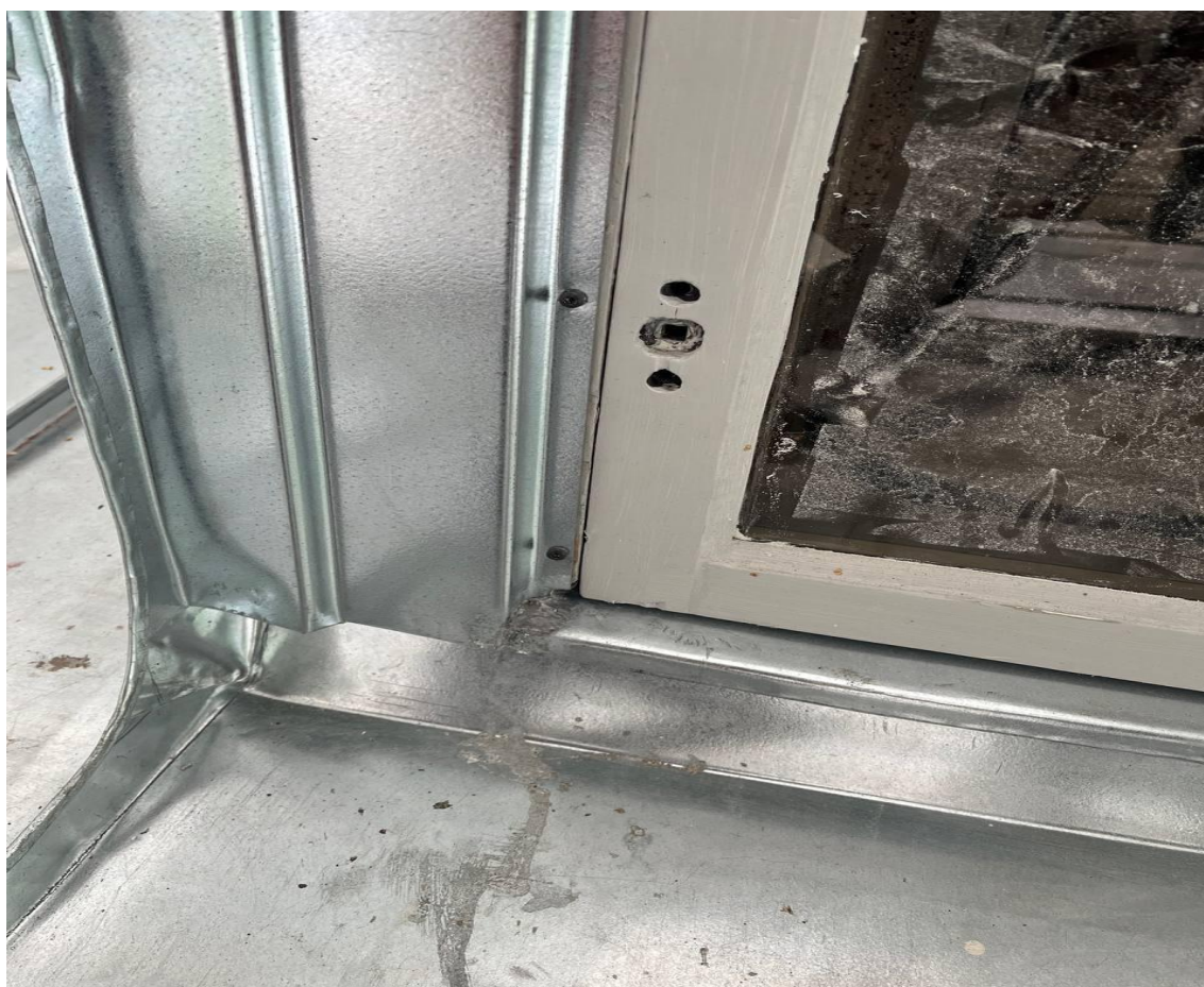
Kuva 9. Liitos juottamis-menetelmällä
