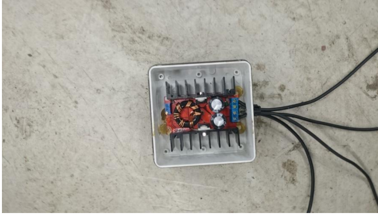
KUVA 19. Jännitteen nostin suojakotelossa ennen lopullista asennusta
