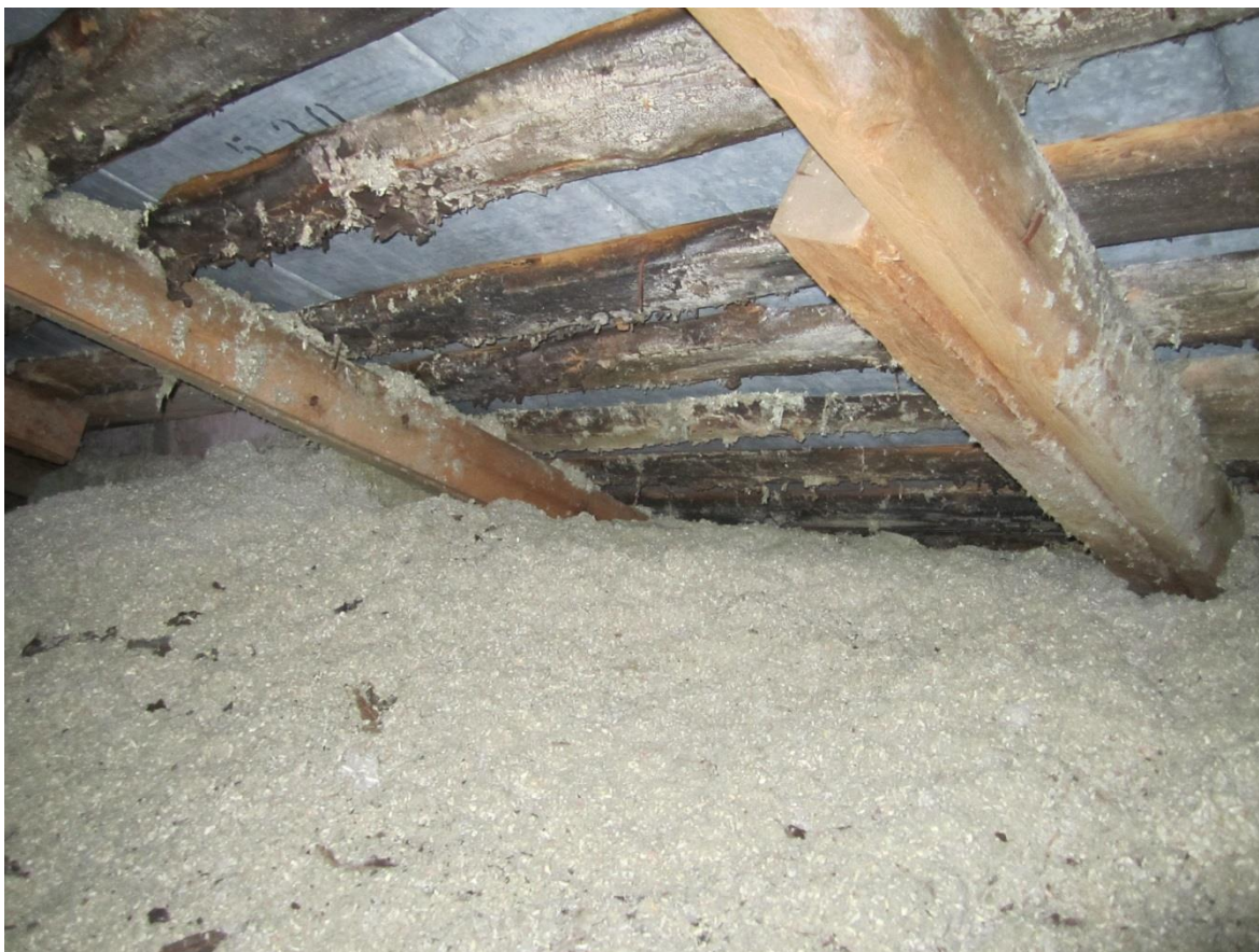
Kuva 6. Yläpohjan eristeen liikätäyttöä.
