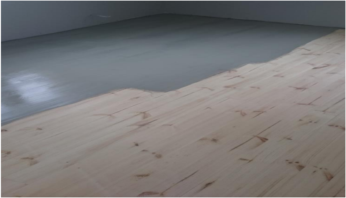
Kuva 18. Lattian maalaus käynnissä.
