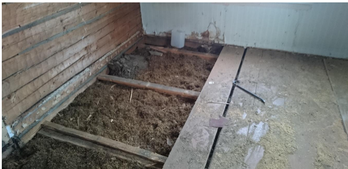
Kuva 10. Lattialankkujen irrotusta.
