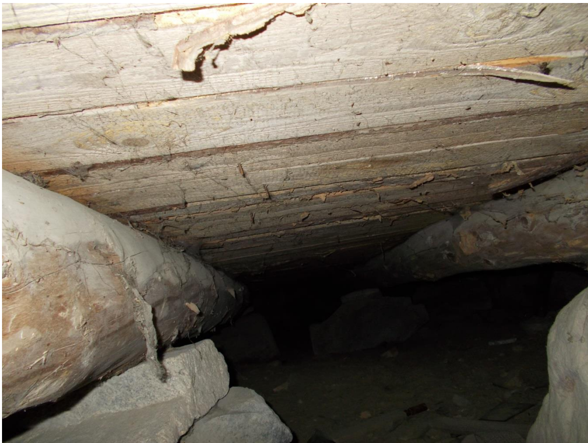
Kuva 3. Idän puoleisen päädyn rossipohjaa.
