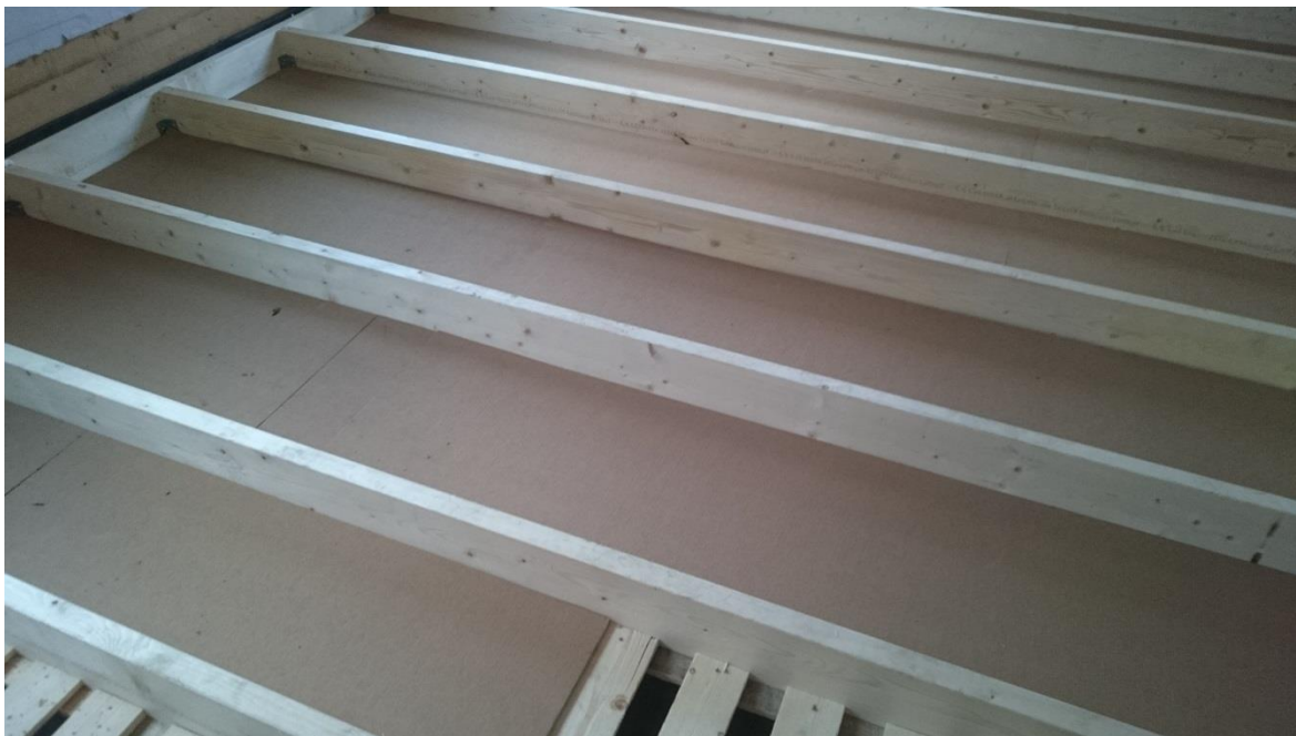
Kuva 16. Puukuitulevyjen asennusta.
