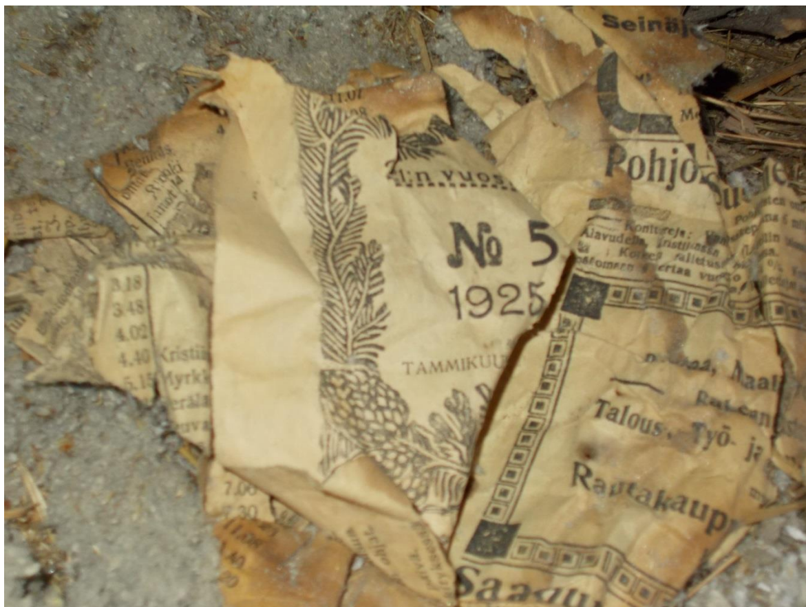
Kuva 7. Yläpohjan eristeitä.
