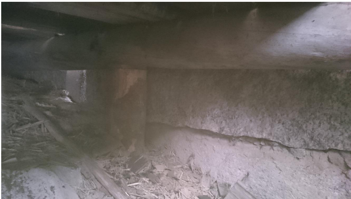
Kuva 12. Alapohjan kannatinpuut.
