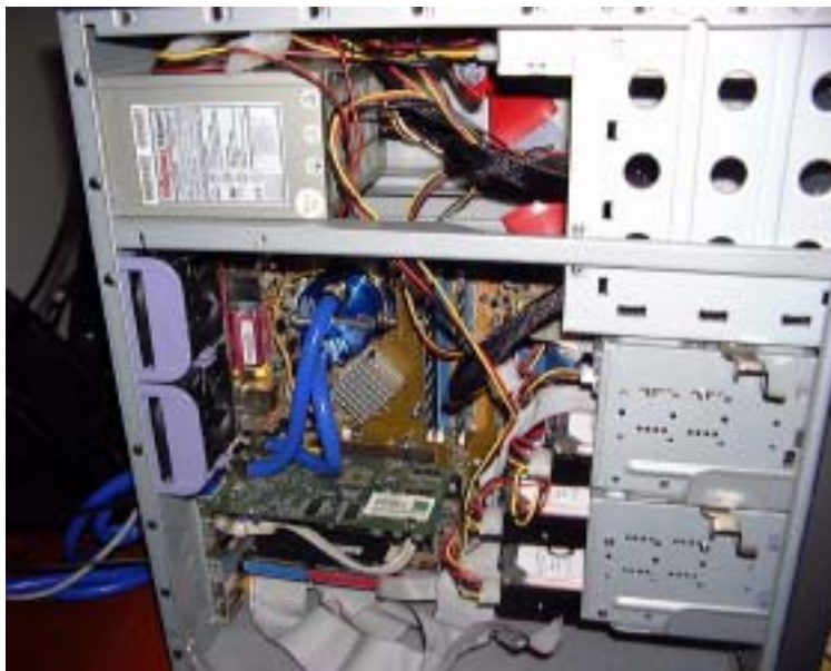
Kuva 5. PC-tietokoneeseen asennettu nestejäähdytysjärjestelmä, ( http://fi.wikipedia.org/wiki/Kuva:Interiorofawatercooledcomputer.png )
