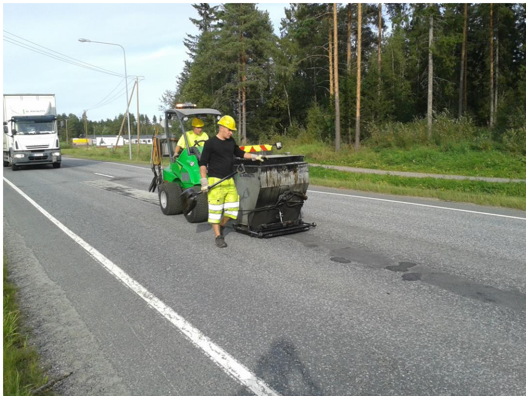
Kuva 6. Reikäsarjojen valuasfalttipaikkausta pienkuormaajalla.
