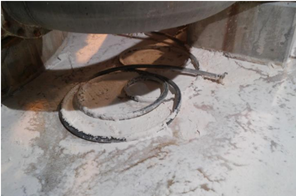
KUVA 5. Lattialle valunutta ja kuivunutta massaa. (Lampela 2017.)
