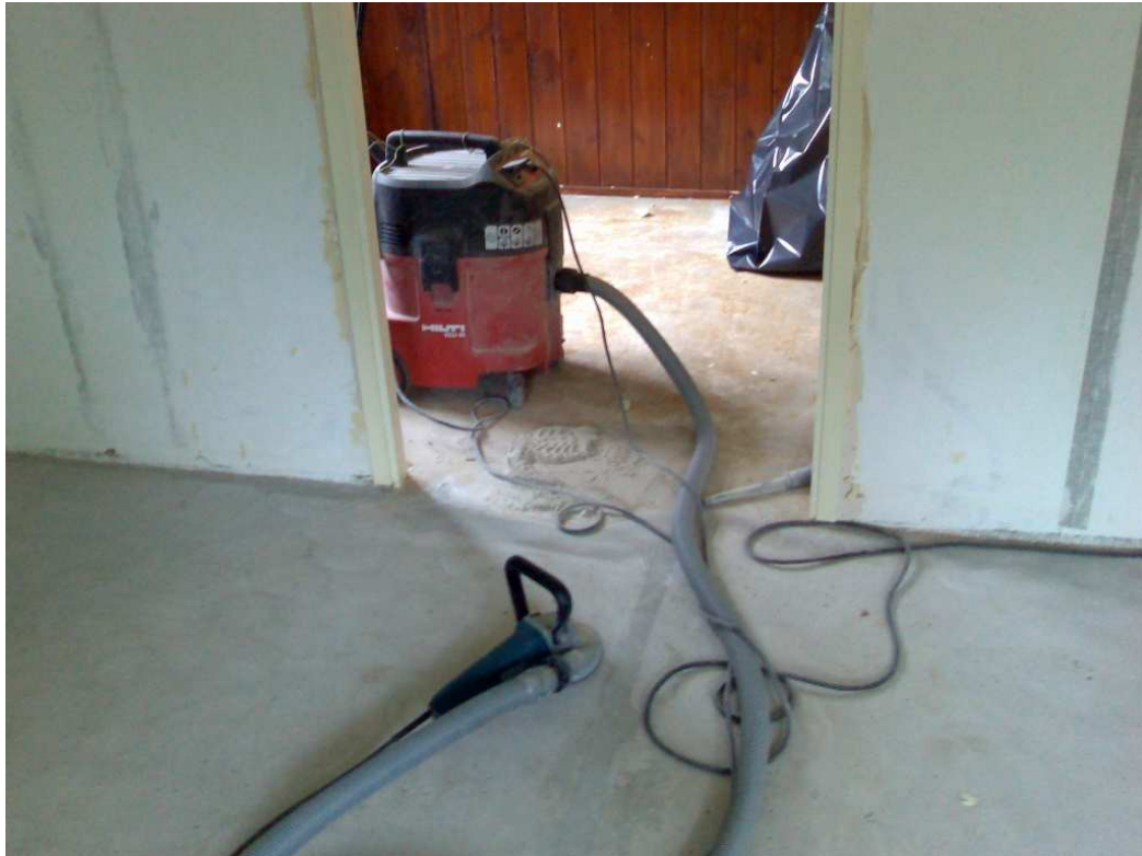
Kuva 9. Kohdepoistolaitteena purkutyössä käytettävä pölynimuri ja jyrsin.
