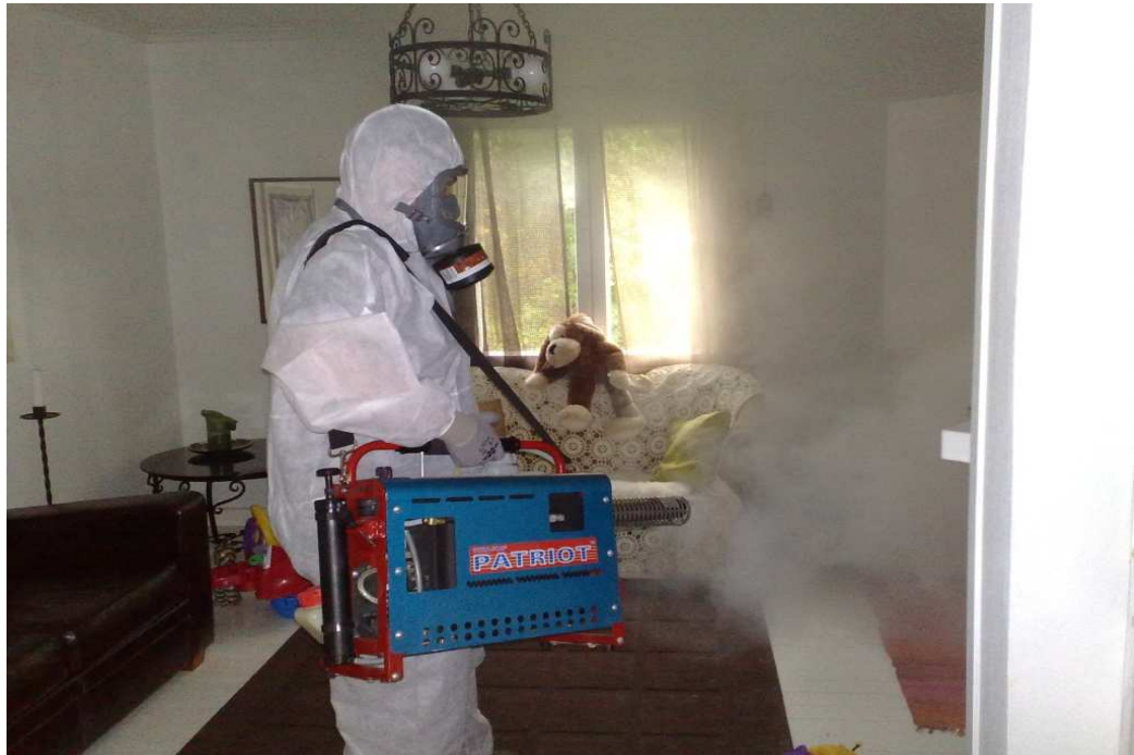
Kuva 3. Orgaanisen peroksidin levitys kohteessa.
