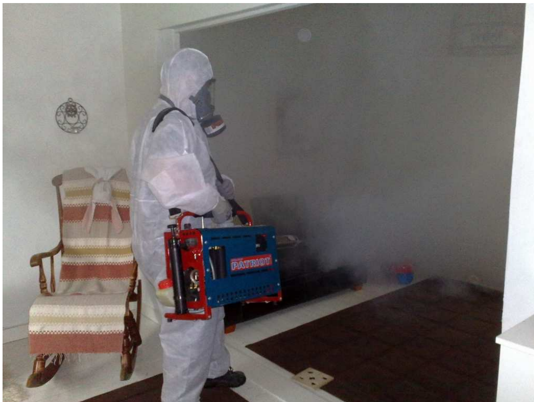
Kuva 4. Orgaanisen peroksidin levitys kohteessa.
