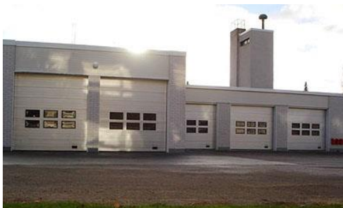
Kuva 18. Noormarkun paloasema (Satapelastus.fi, 2018)
