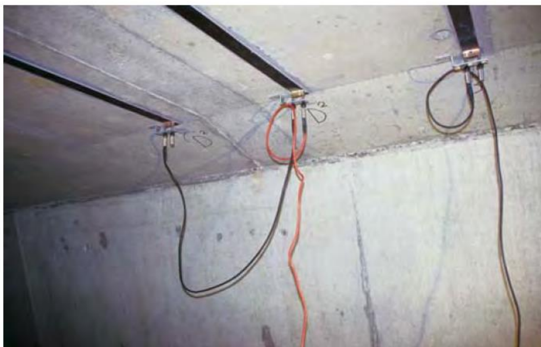
kuva 1. Liiman lämpökovetusta sähkövastuksilla. (Externally bonded FRP reinforcement for RC structures 2001, 16)
