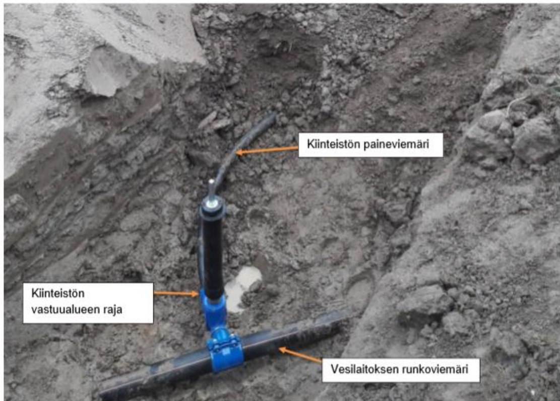
Esimerkki liittymisestä paineviemäriin.
