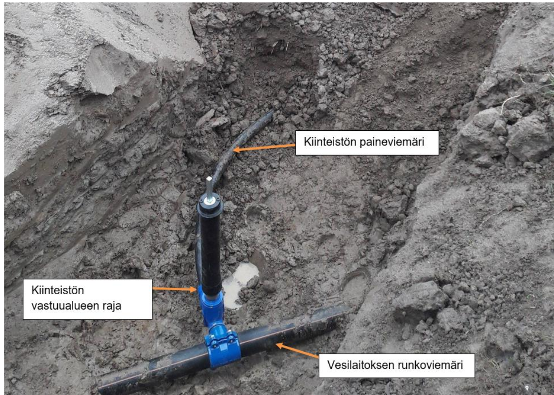
KUVA 6. Esimerkki liittymisestä paineviemäriin (Kangasalan kaupunki 2019).
