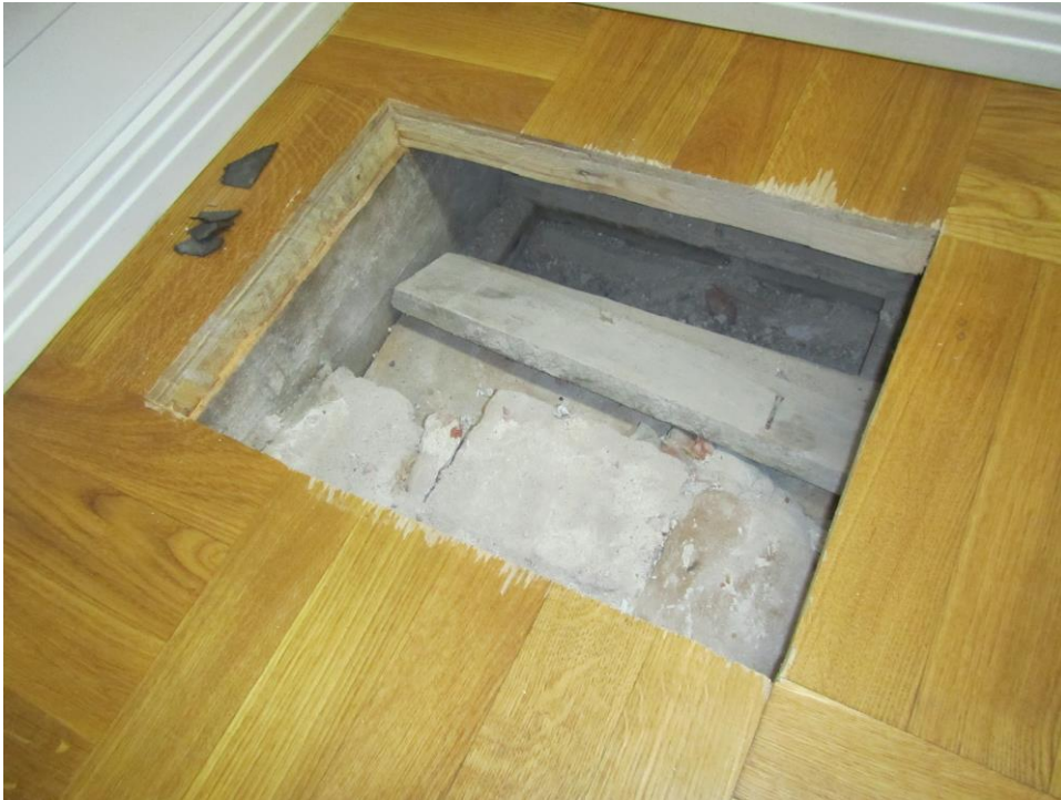
Kuva 9: Lattiarakenteen tarkastus rakenneavauksen kautta. (Maximillian Alopaeus)
