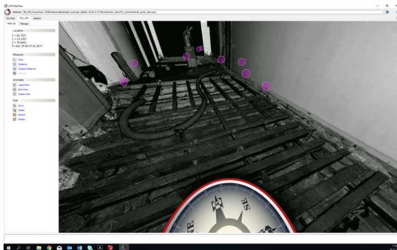
Kuva 13: Laserkeilauskuvat samasta kohdasta kuin kuvassa 14, purkutöiden jälkeen. (Maximilian Alopaeus)
