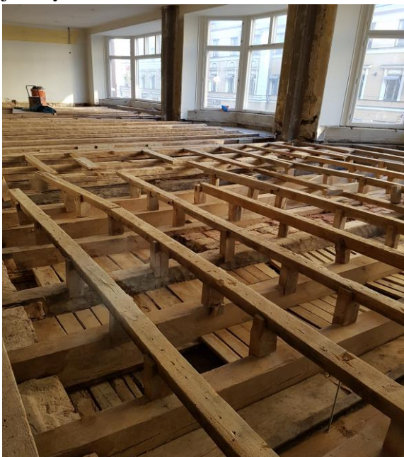
Kuva 10: Tarkennettu rakenne purkutöiden jälkeen. (Maximillian Alopaeus)
