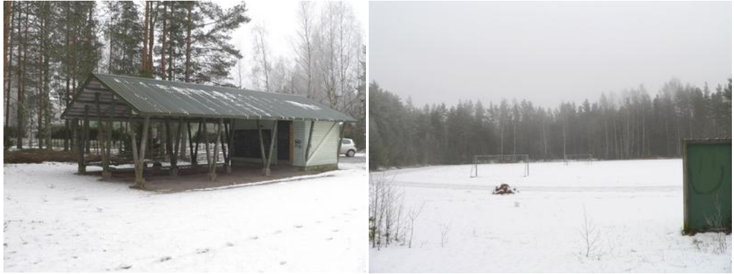
KUVIOT 14, 15. Kentän pääsisäänkäynnin yhteydessä sijaitsee katoksellinen huoltorakennus. Talvisin kenttä toimii ovaalin muotoisena hiihtolatuna.
