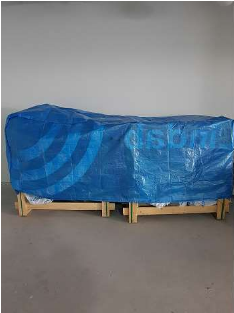
Kuvio 3. IV-putket varastoituna irti lattiasta ja suojattuina
