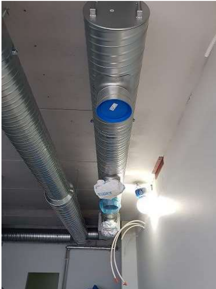
Kuvio 4. IV-putket asennuksen jälkeen suojattuina
