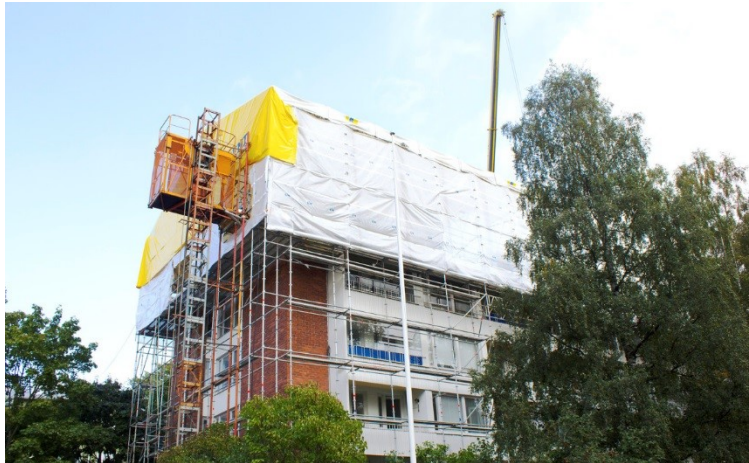
Kuva 16. Lisäkerrosrakentamista puuelementeistä sääsuojan alla (Koskisen Oy n.d.).
