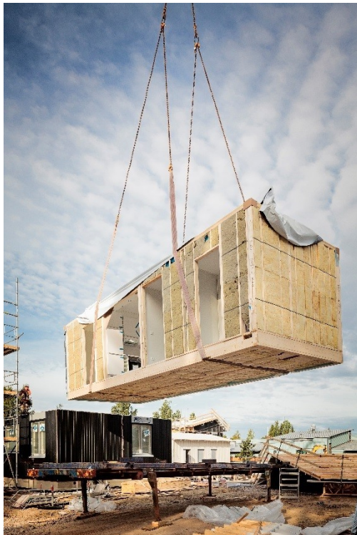
Kuva 15. Puurakenteinen tilaelementti (Puuinfo n.d.c).
