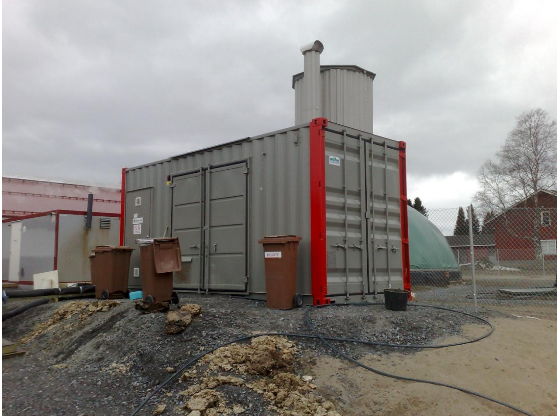
KUVA 1. Savonia-ammattikorkeakoulun liikuteltava biokaasulaitos. Taustalla MTT:n Mansikki-biokaasulaitoksen kaasuväri.
