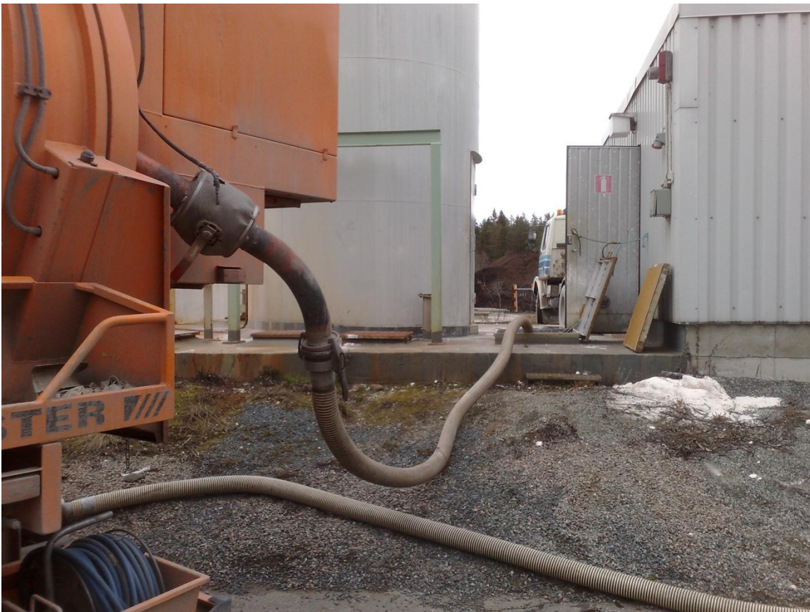
KUVA 7. Jätevesilietteen imu sakeutusaltaasta loka-autoon Siilinjärven jätevedenpuhdistamolla.
