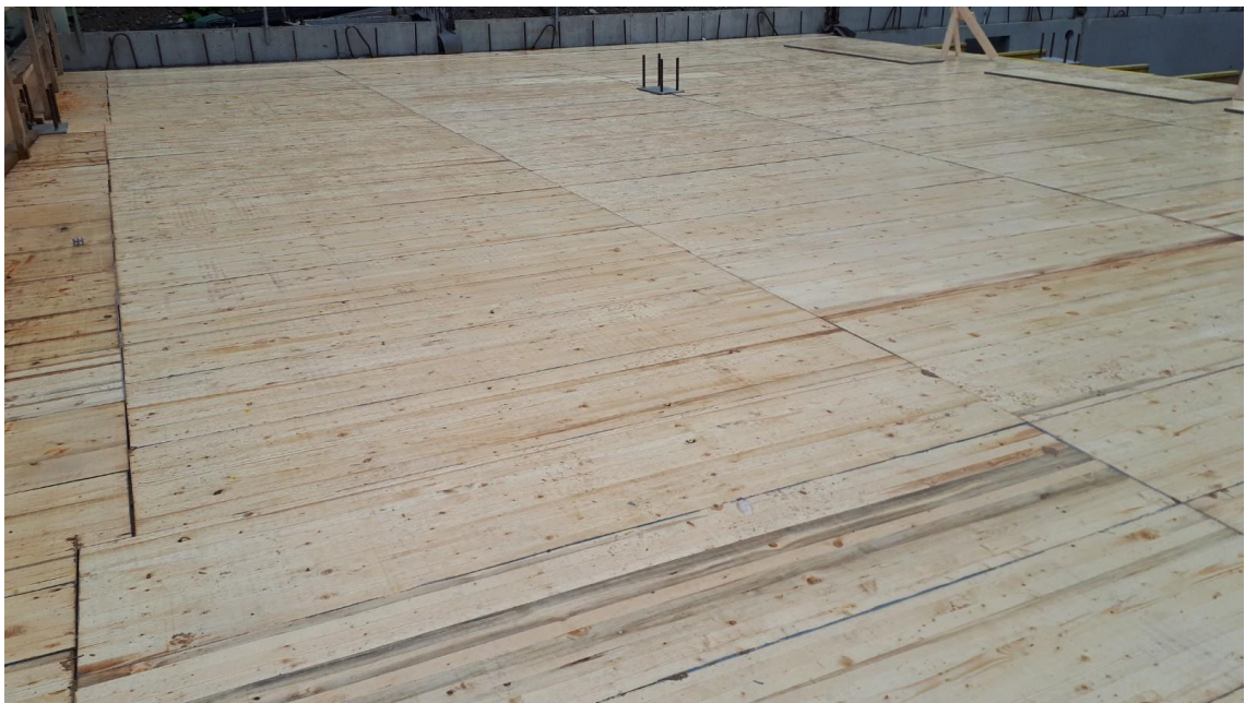
KUVA 4. Paneelit asennettuna palkkien päälle
