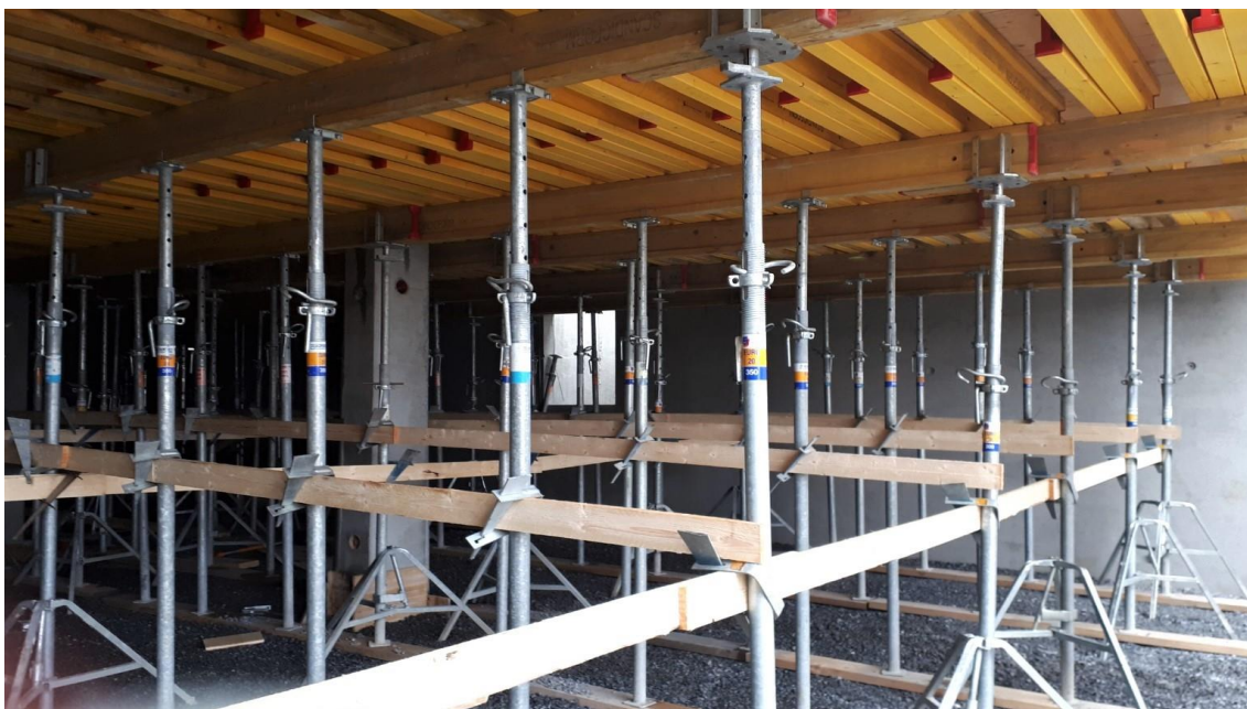
KUVA 3. Valmis vakiopalkeista rakennettu hoivimuotti
