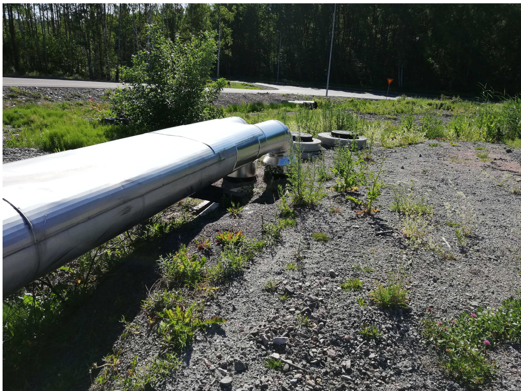
Kuva 21. Kaukolämpöputket johtavat kaivantoon alittaen tien. (Lintukorpi, 2019)
