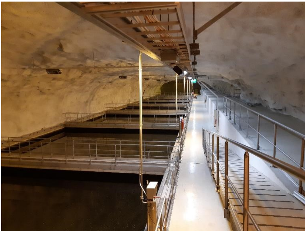
KUVA 10. Biologiset suodatinlaitteet
