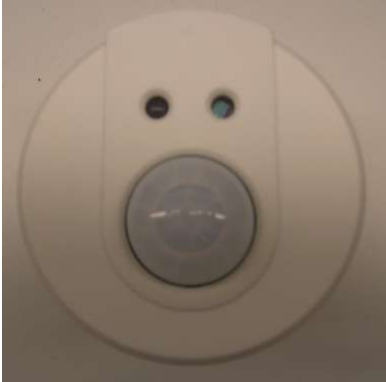
KUVA 10. Multisensori etupuolelta kuvattuna (Kuva: Jarno Nurmio 2010)
