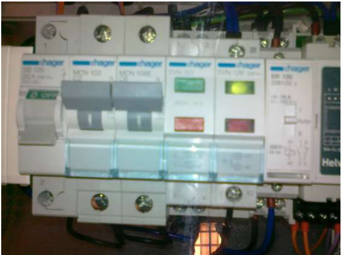
KUVA 1. Teholähteen on- ja off-kytkimet sekä merkkilamput (Kuva: Jarno Nurmio 2011)
