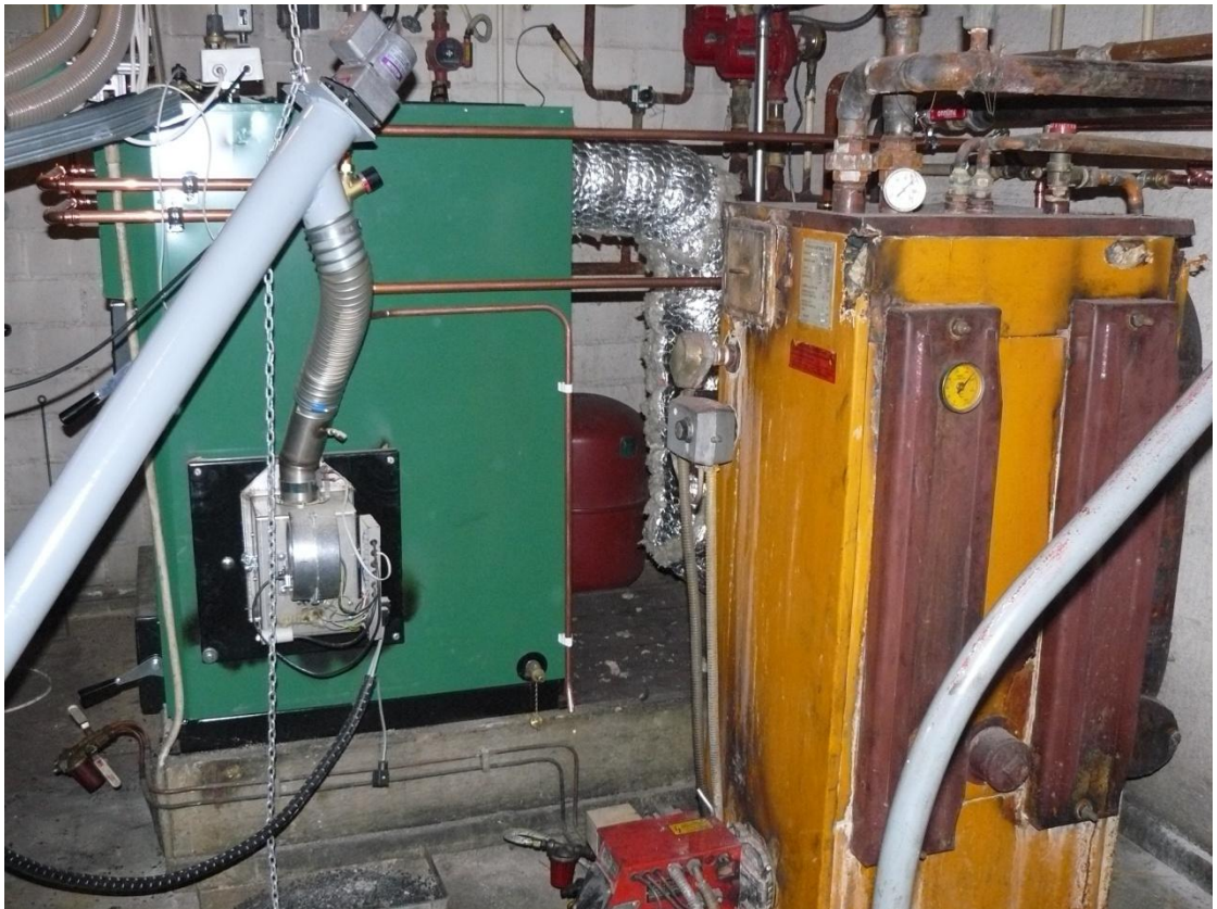
KUVIO 2. HT Enercon pellettikattila (vas.) asennettuna vanhaan kattilahuoneeseen öljykattilan rinnalle.
