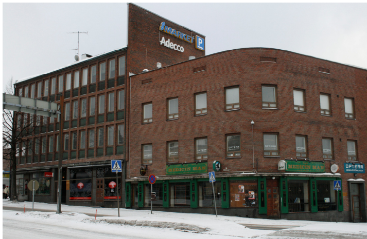
Kuva 4. Julkisivu Medicin Man ja Level 5
