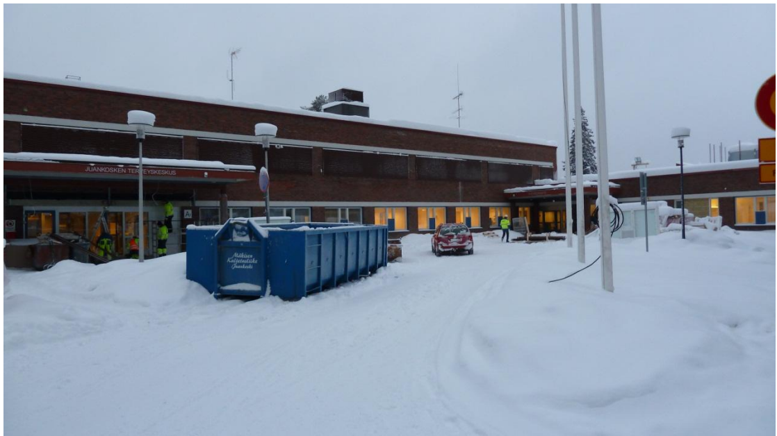
KUVA 1. Juankosken terveyskeskus peruskorjauksen ollessa vielä käynnissä. (Kuva Juuso Itkonen 2011)
