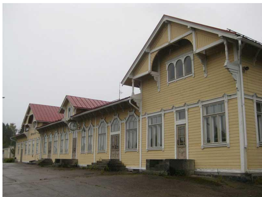
KUVA 8: Haapamäen asemarakennus (Lehto, 2010)
