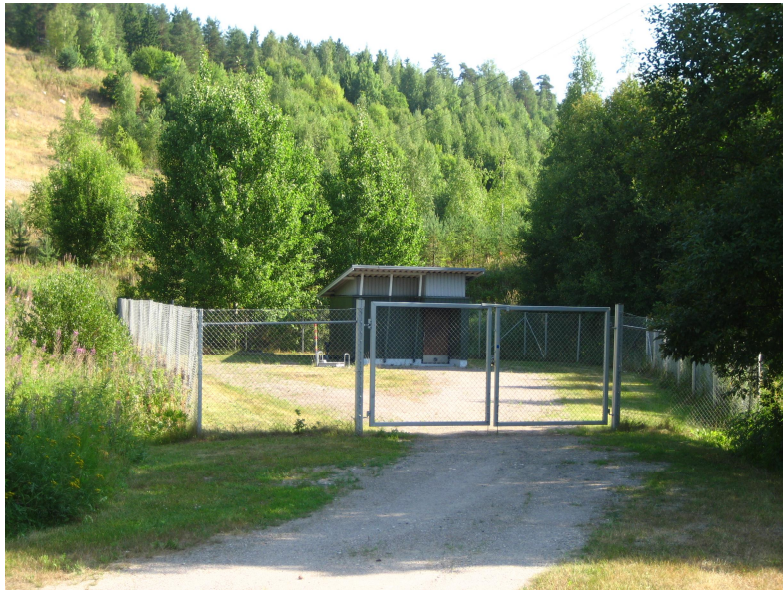
KUVIO 52. Vedenottamon ympärille on jätettävä riittävä suoja-alue (Wuori 2010)
