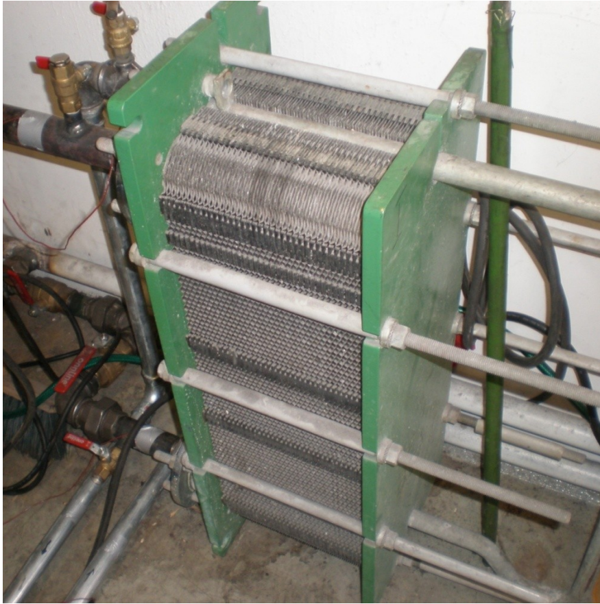
KUVIO 23. Lämmönvaihdin kiinteistön lämpöverkkoon
