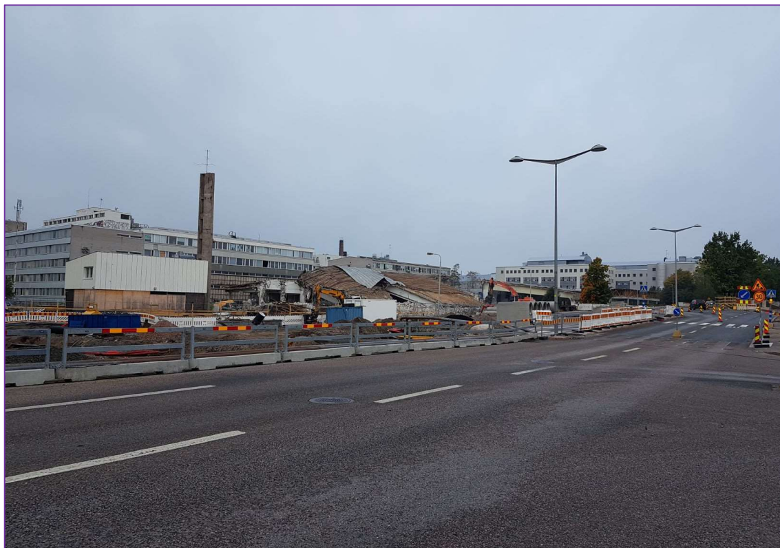
Kuva 8. Kutomotie 1 nykyisten rakennusten purkaminen syyskuu 2020. Kuva Janita Viljan- der
