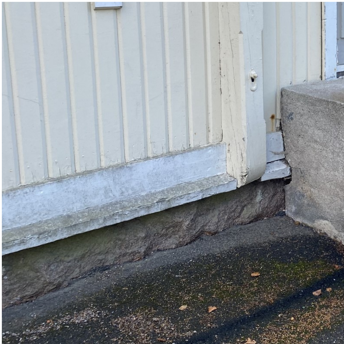
Kuva 12. Alalauta ja tippalauta pidättävät vettä verhousta vasten. Kasvusto heikentää veden poistumista.
