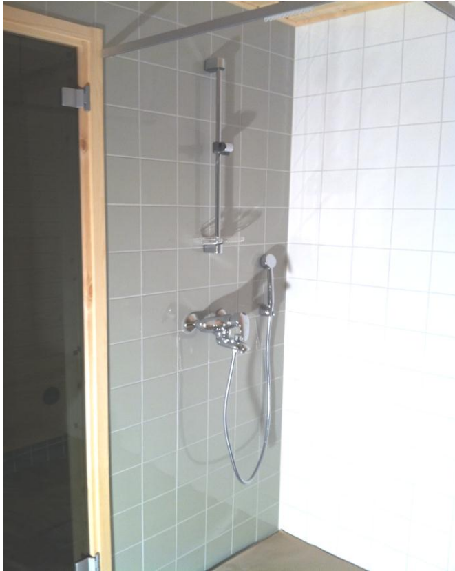
KUVA 6. Tehosteseinä Upofloor Base Cement Grey 15x15 (M.Alajärvi)
