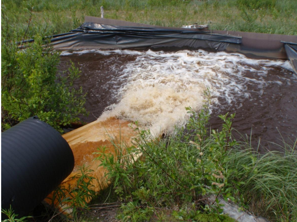
Kuva 16 Laskeutusaltaasta vesipumpataan jako-ojaan, josta vesi ohjataan pintavalutuskentälle. Kuva Enni Karvinen 2010.
