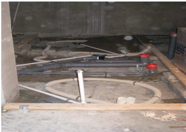
KUVIO 4. Ennen kevytsorabetonin valua suoritettut työt, Kelokatu 3
