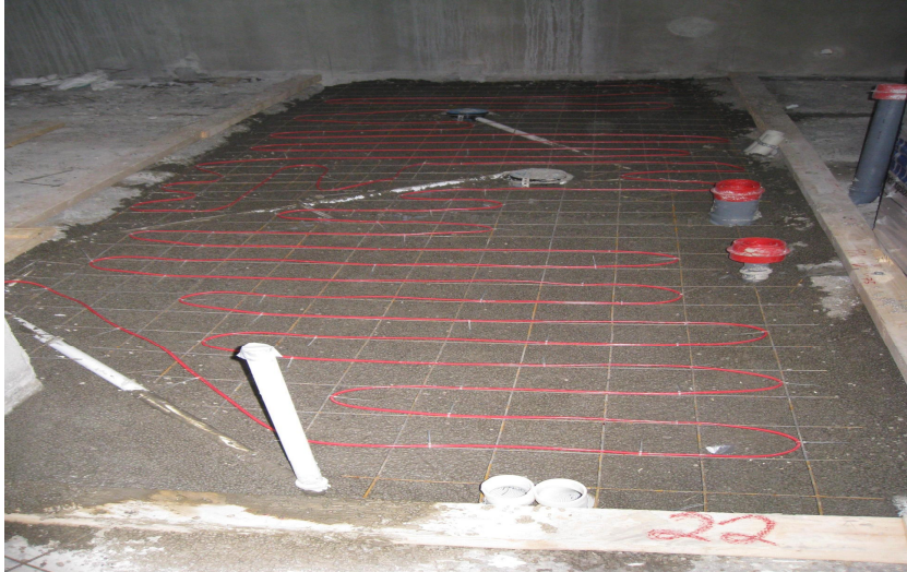
KUVIO 7. Kevytsorabetonoinnin jälkeiset työt ennen pintavalua
