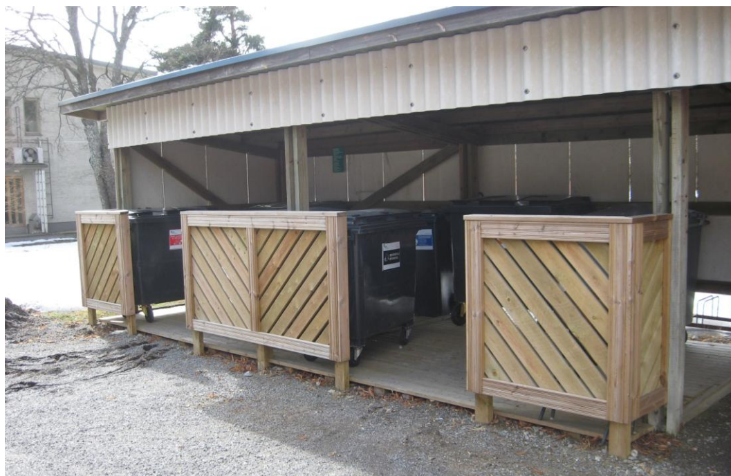
Kuva 5. Jätteiden lajittelupiste, joka sijaitsee pajarakennuksen vieressä.
