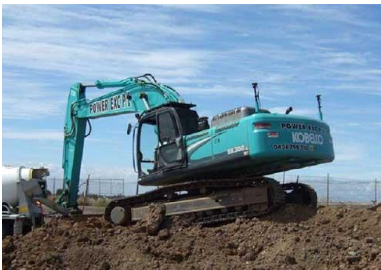
Figur 25. Grävmaskin utrustad med maskinstyrning och dubbla GNSS-antennerna bakpå. 108
