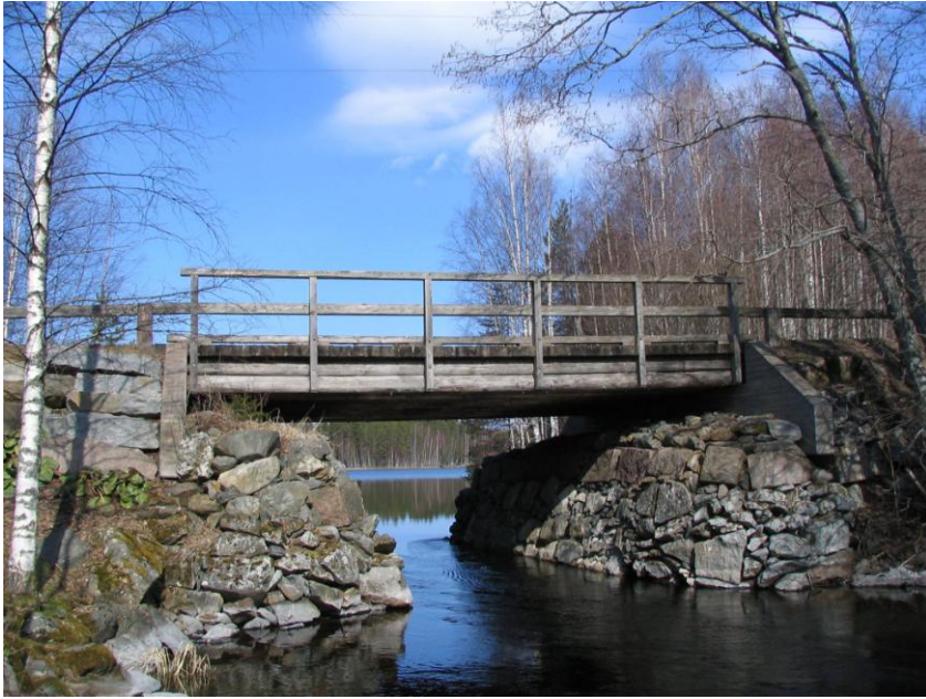
Kuva 4. Raikuun kanavan silta (Liikennevirasto).
