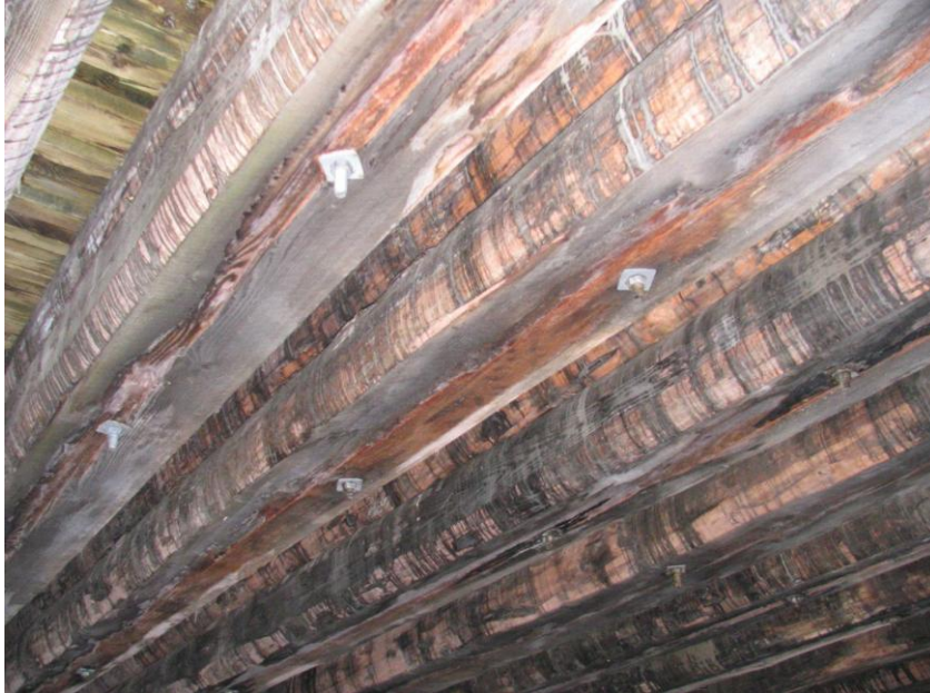
Kuva 6. Sillan pääkannattimet (Liikennevirasto).
