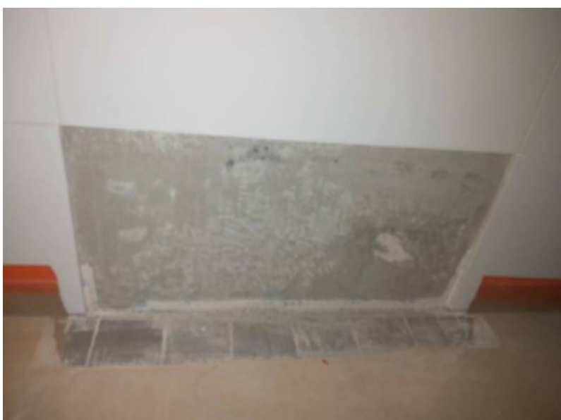
KUVA 12. Laatan vaihto, vesieristyksen poisto
