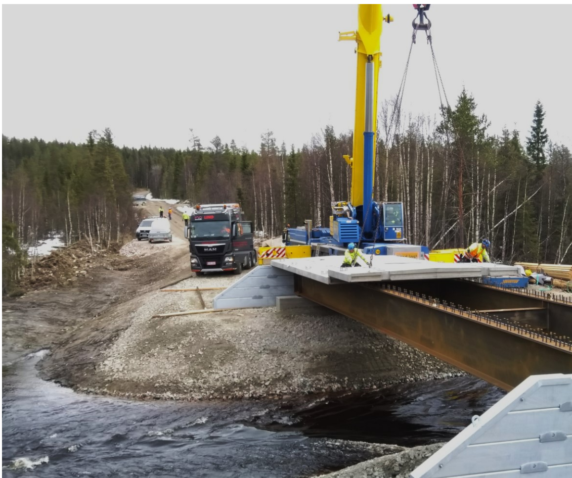
KUVA 4. Korojoelle asennettiin Ruukin Easy Bridge (Ruukki 2018)
