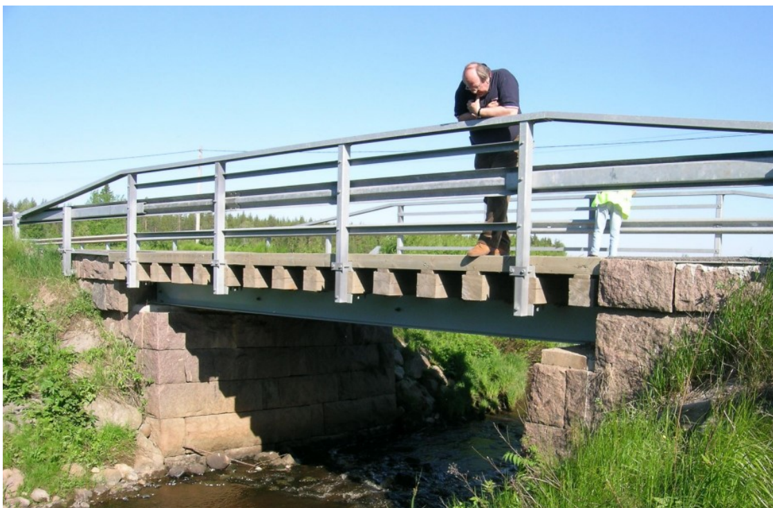
KUVA 3. TVH 722069:n mukainen puukantinen teräspalkkisilta (Tiehallinto 2008)
