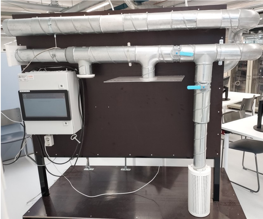
KUVA 2. Ilmanvaihtolaitteiston toinen puoli, vasemmalla automaatiojärjestelmä
