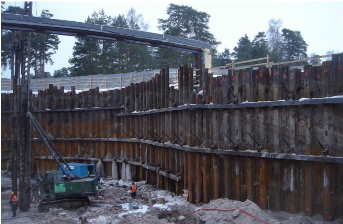
KUVA 5. Teräsponttiseinä (Liikennevirasto 2016, 1)
