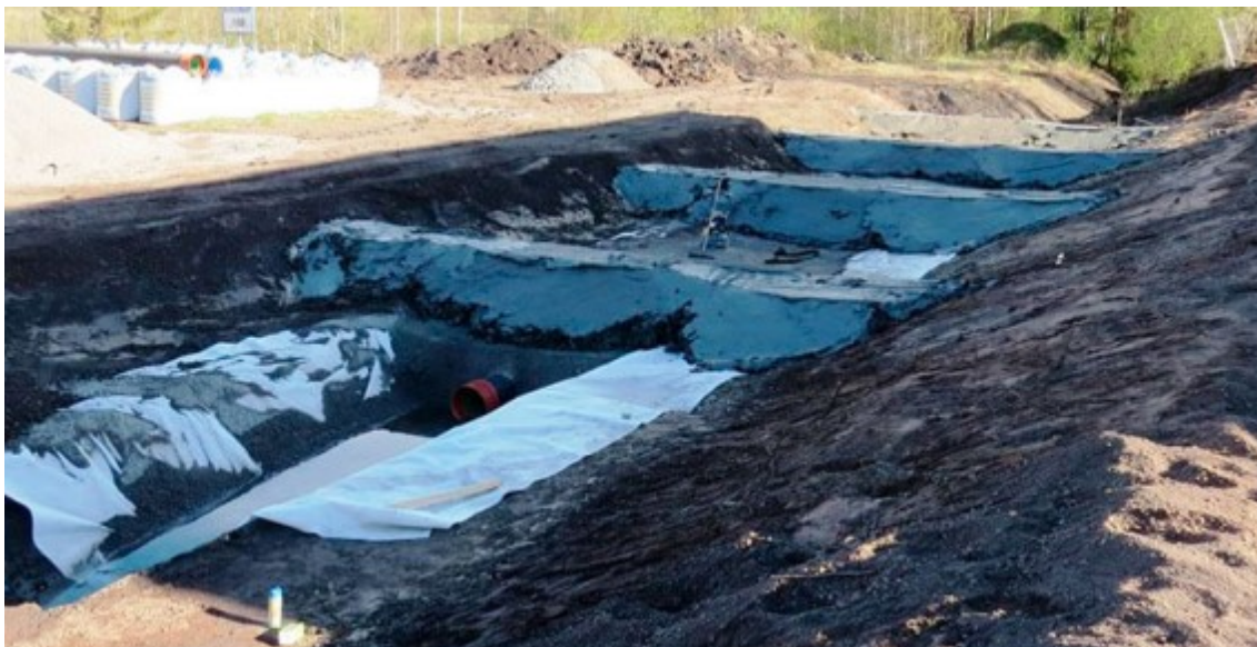
KUVA 4. Luiskattu kaivanto. (Leca 2021.)
