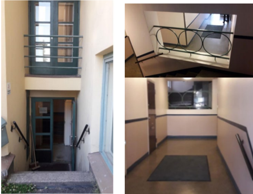
Kuva 4. Sisäänkäynti sisäpihalta porraskäytävään. Porraskäytävän pihaovi on uusittu. Parvekkeen ovi ja kaide ovat alkuperäiset. Kuva Timo Hyvärinen.
