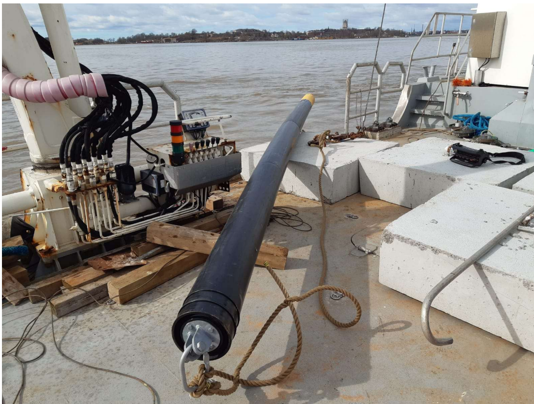
Kuva 2. Viitta kiinni painossa ja valmiina asennettavaksi.
