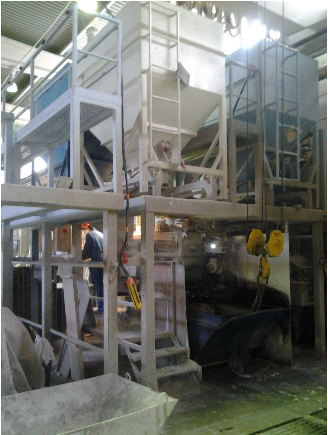
Kuva 11. Mikkelin tehtaan rouheasema
